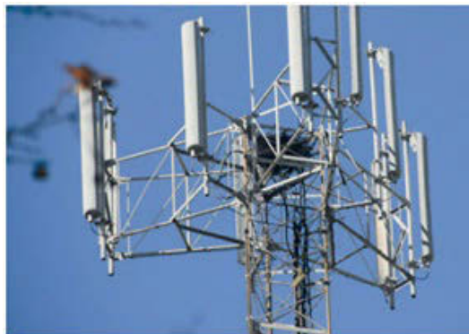
Εικόνα 2.4 Κεραία Κυψέλης
