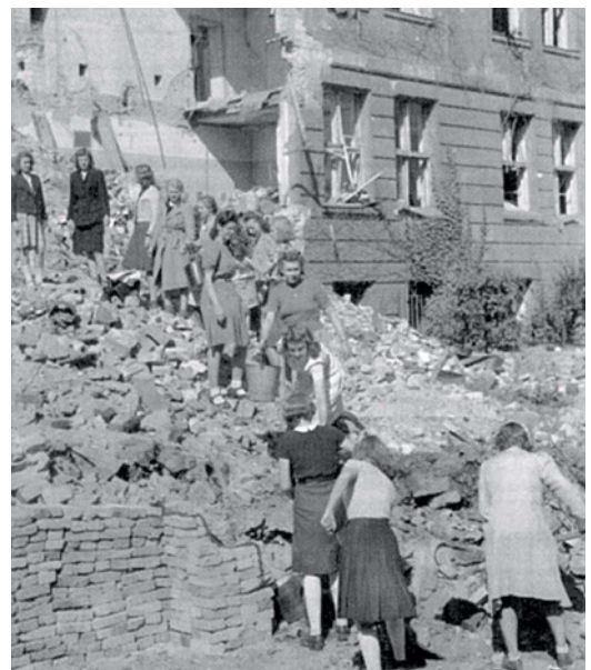
3. Γερμανία, Βερολίνο, 1945: Μαθήτριες καθαρίζουν ερείπια.
