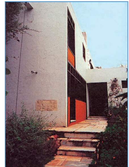
93. Είσοδος μονοκατοικίας, όπου διακρίνουμε τα διαδοχικά στάδια προσπέλασης στην κατοικία. Κατοικία στο Παλαιό Ψυχικό. Αθήνα.
