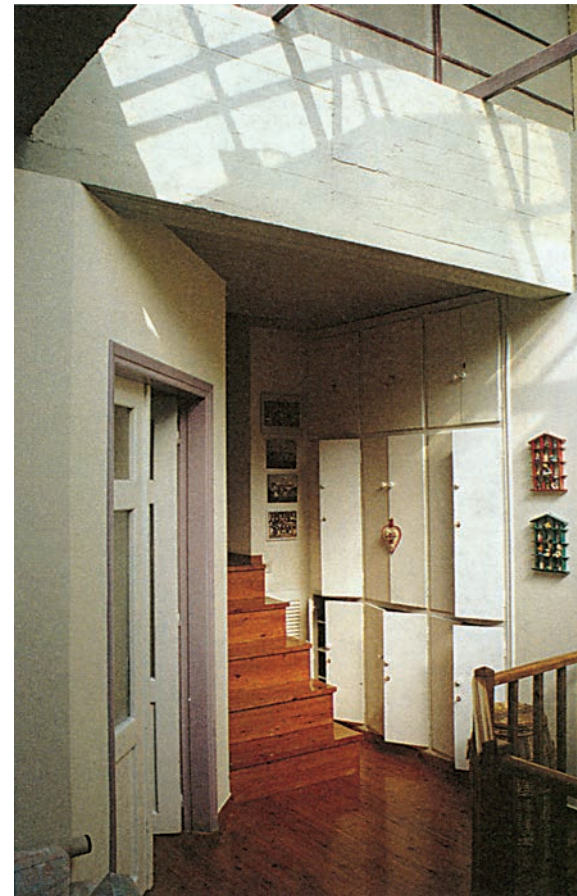
41. Βορινός φωτισμός από άνοιγμα στην οροφή.
