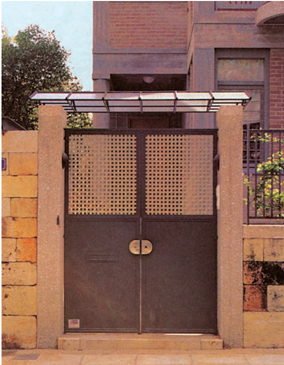
201. Πόρτα αυλής σε κατοικία στη Φιλοθέη.
