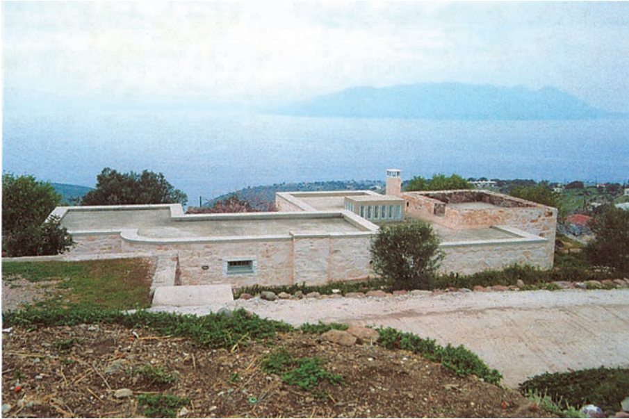
67. Το δώμα, η "πέμπτη" όψη του κτιρίου. Κατοικία στο Σφεντούρι, Αίγινα.
