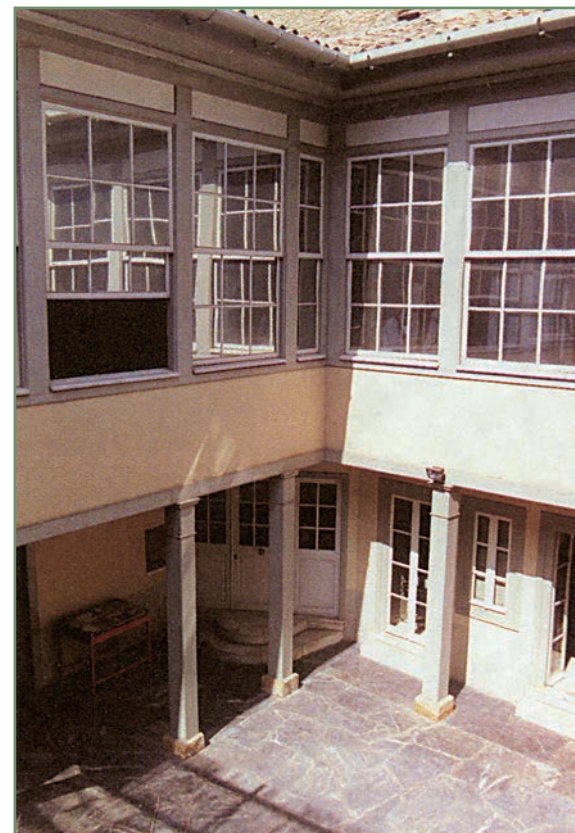
188. Παλιά Αθηναϊκή κατοικία με αίθριο, μετά τις εργασίες ανακαίνισης. Πλάκα, Αθήνα.
