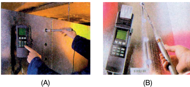
Σχήμα 9-7: Μέτρηση της ταχύτητας του αεραγωγού με σύγχρονο εξοπλισμό (η άνω οπή μέτρησης φαίνεται να απέχει αρκετά από τα τοιχώματα, αλλά αυτό συμβαίνει επειδή υπάρχει η μόνωση του αεραγωγού).
