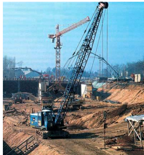
Εικόνα 23.2: Κατασκευή δρόμου στη Γερμανία
