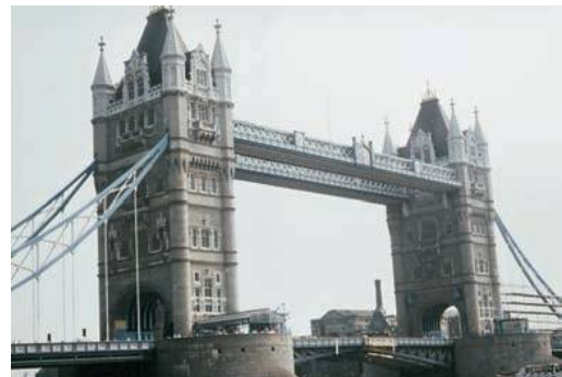
Εικόνα 31.6: Η γέφυρα του Πύργου του Λονδίνου
