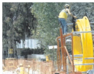
Τοποθέτηση αγωγού φυσικού αερίου
