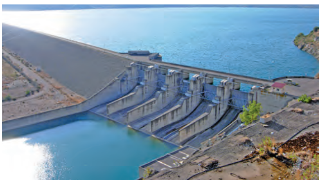
Το φράγμα και η τεχνητή λίμνη Στράτου
