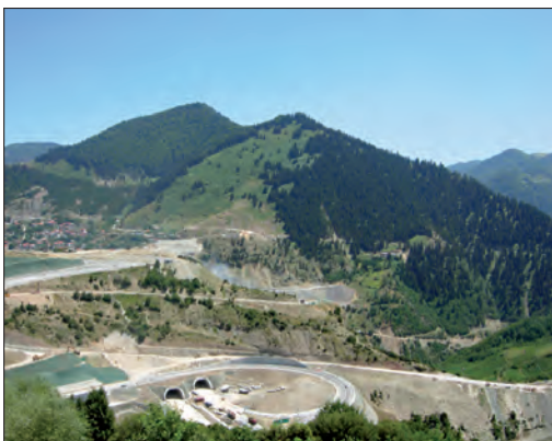
Σήραγγα στην Εγνατία Οδό
