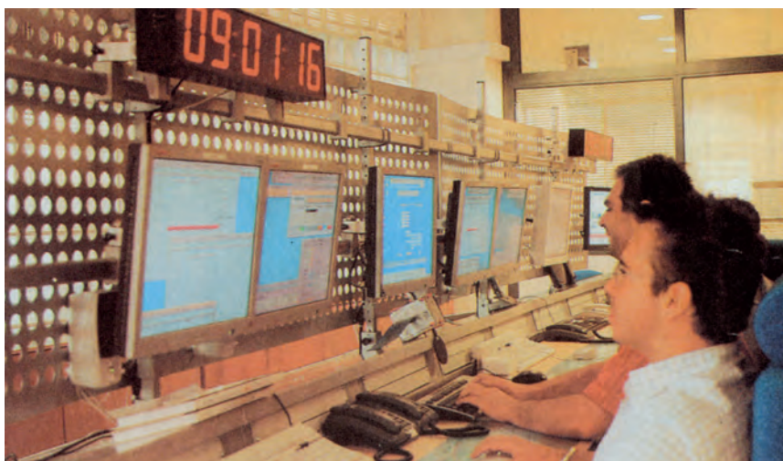
Εικ. 6.5a Κέντρο ελέγχου του δορυφόρου Hellas-Sat 2: υποδομή υποστήριξης για σύγχρονες μορφές επικοινωνίας και τηλεργασίας (ΒΗΜΑΓΑΖΙΝΟ 18/9/2005).
