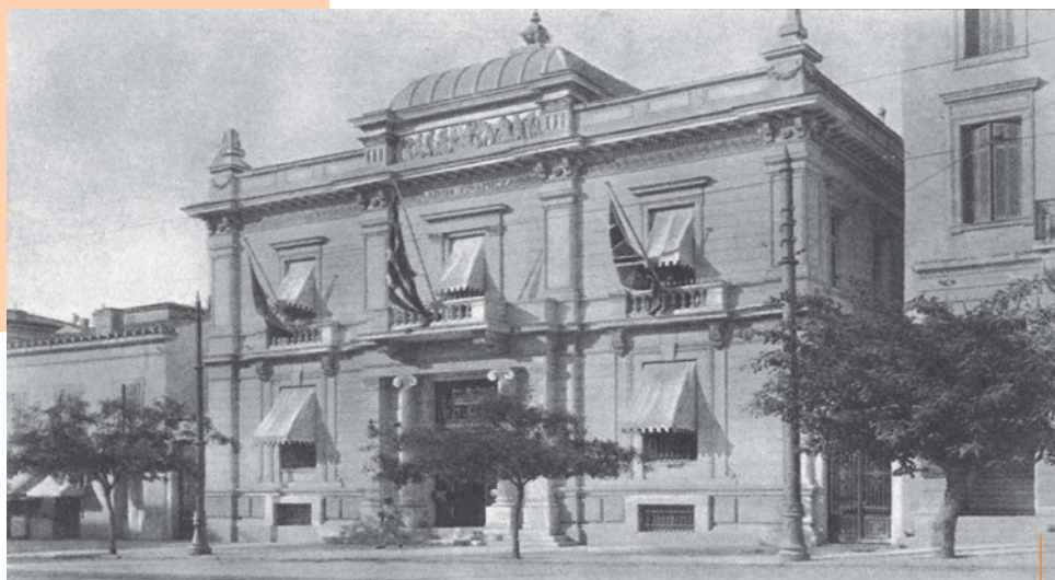
Το κτίριο της Λαϊκής Τράπεζας στην οδό Πεσμαζόγλου
