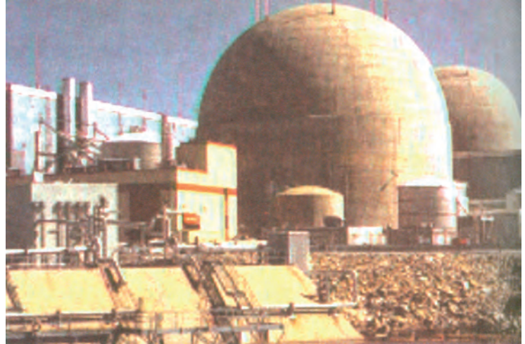
Εικ. 4.7 Πυρηνικό εργοστάσιο παραγωγής ηλεκτρικής ενέργειας στη Βιρτζίνια των Η.Π.Α. Παράγει ηλεκτρική ισχύ 900 MW και ταυτόχρονα αποβάλλει στο κοντινό ποτάμι θερμότητα με ρυθμό 2100 MW. Το εργοστάσιο αυτό όπως και τα υπόλοιπα του είδους του «πετάει» πολύ περισσότερη ενέργεια από όση αποδίδει σε χρήσιμη μορφή.
