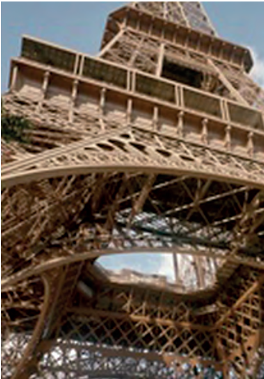
Λεπτομέρεια από τον Πύργο του Αιφελ. Το ασάλι αποτελεί το νέο υλικό-σύμβολο της σύγχρονης εποχής.
