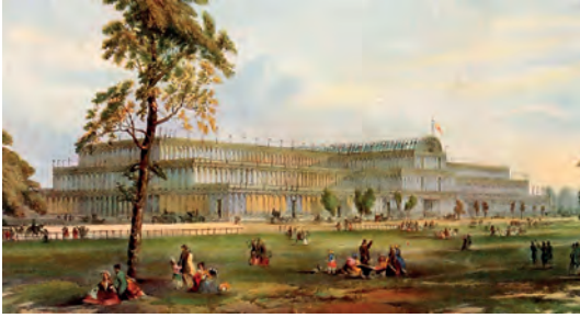
Το Κρυστάλινο Παλάτι, κτήριο που κατασκευάστηκε ειδικά για τις ανάγκες της Μεγάλης Έκθεσης στο Λονδίνο το 1851. Νέα υλικά χρησιμοποιήθηκαν για την ανέγερσή του όπως γυαλί και ασάλι.
