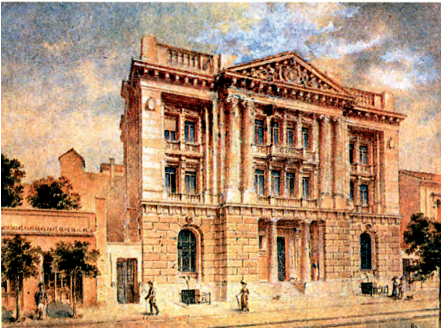
Αθήνα, Νεοκλασικό κτίριο
