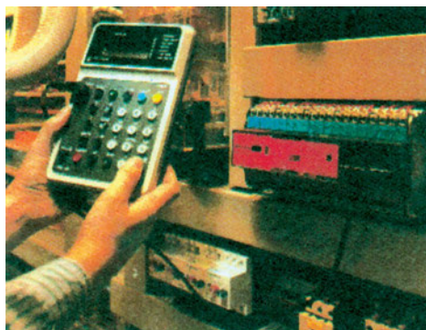
Σχήμα 9: Έλεγχος βλαβών σε εγκατάσταση αυτοματισμού με PLC.
