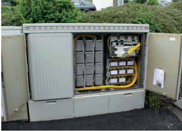
Εικόνα 5.1.4.1.β: Εξωτερικό DSLAM
