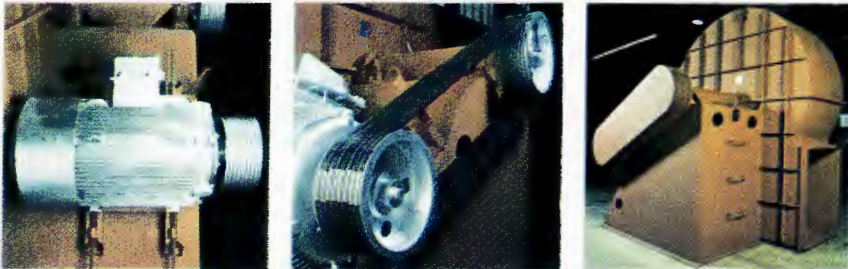
Εικ. 14.9.α Ιμαντοκίνηση παραδείγματος εφαρμογής
