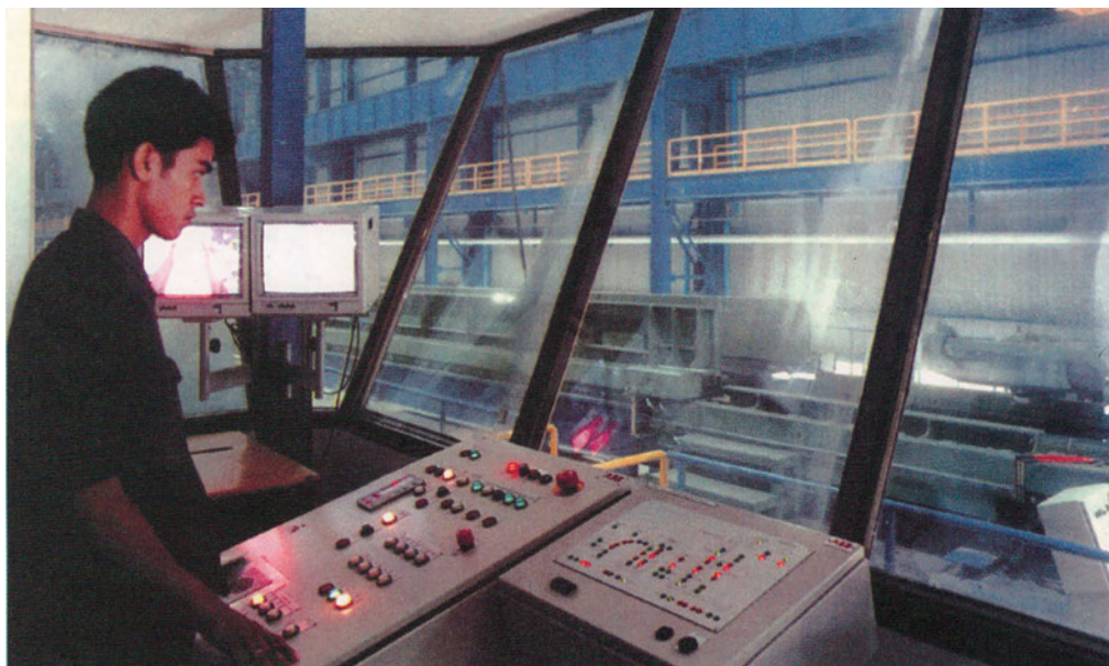
Σχήμα 3.10: Τράπεζα χειρισμών εγκατάστασης αυτοματισμού.
