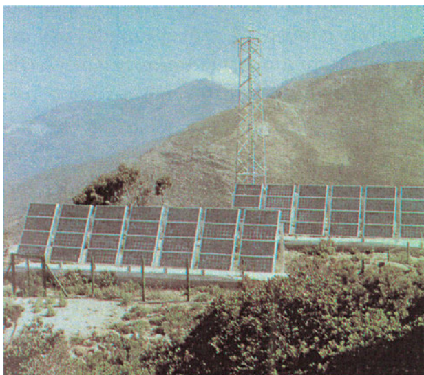
Σχήμα 6.4.2: Φωτοβολταϊκή συστοιχία
