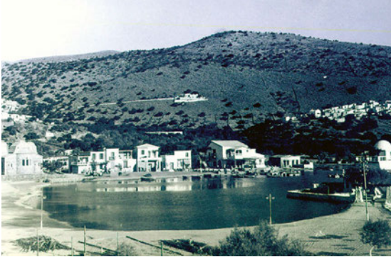
φωτ. 4.1 Λιμάνι, Ελούντα Κρήτης, 1963
