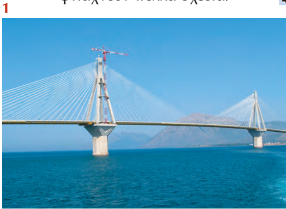
Η μεγάλη σύγχρονη γέφυρα στο Ρίο-Αντίρριο (εικ. 1)
