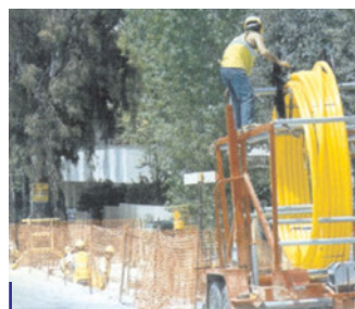
Τοποθέτηση αγωγού φυσικού αερίου
