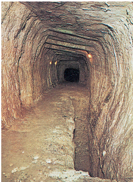
Το υδραγωγείο της Σάμου. Την εκτέλεση του έργου ανέθεσε ο τύραννος Πολυκράτης στον αρχιτέκτονα Ευπαλίνο. Η σήραγγα είχε μήκος περίπου ενός χιλιομέτρου και τροφοδοτούσε με νερό την πόλη.
