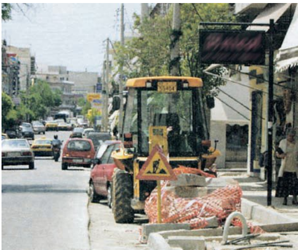
Εικόνα 31.1: Κατασκευή νέων πεζοδρομίων
