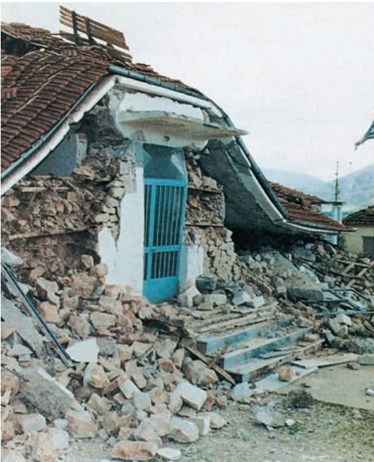
Εικόνα 27.1α: Καταστροφή από σεισμό
