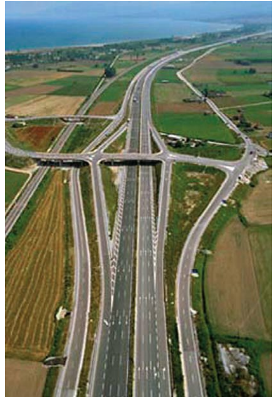
Εικόνα 41.3: Π.Α.Θ.Ε. Νέα Εθνική Οδός. Τμήμα: Δίον-Κατερίνη
