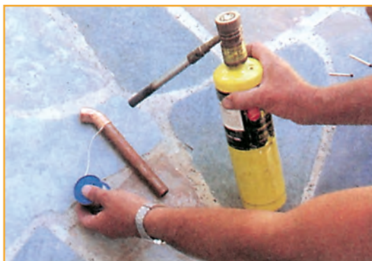
Εικόνα 7.7 Συγκόλληση χαλκοσωλήνα
