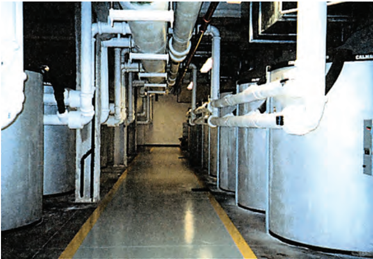
Εικόνα 1.13: Συγκρότημα δεξαμενών για την αποθήκευση πάγου.
