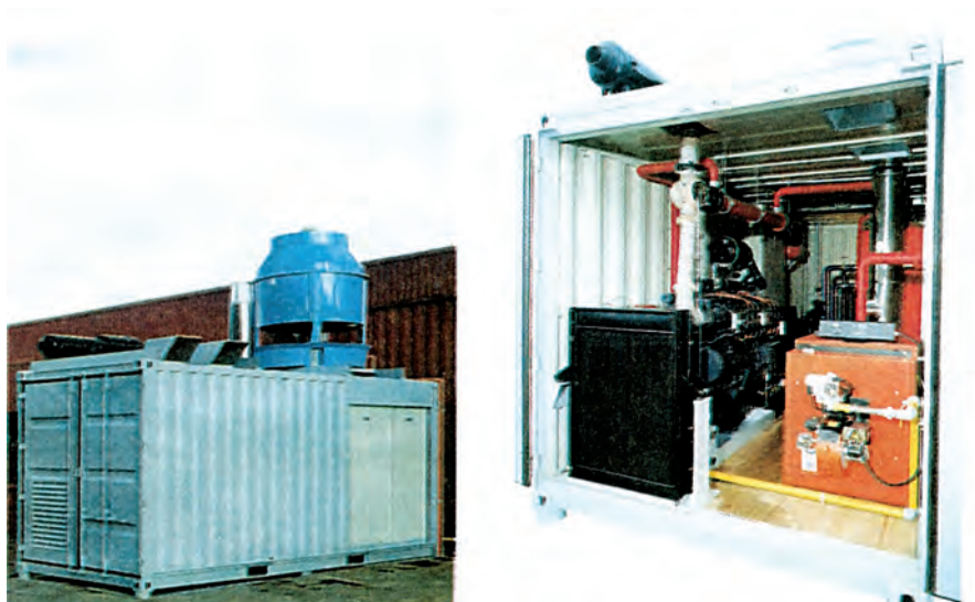
Εικόνα 1.11: Μονάδα συμπαραγωγής ηλεκτρικής ενέργειας – θερμότητας - ψύχους. Αριστερά εξωτερική μονάδα και δεξιά λεπτομέρεια από τον εσωτερικό χώρο της μονάδας.
