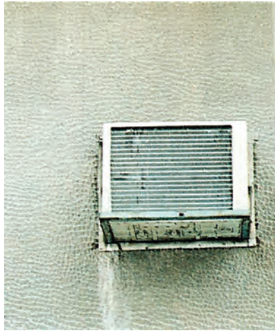
Εικόνα 1.7: Ενιαίου τύπου κλιματιστική μονάδα που τοποθετείται σε μια μεγάλη τρύπα στον τοίχο.
