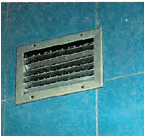
Ορθογωνικό στόμιο τοίχου, με ρυθμιζόμενα πτερύγια.
