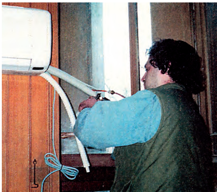
Εικόνα 3.14: Προετοιμασία συνδέσεων εσωτερικής μονάδας που θα «περάσουν» στην εξωτερική πλευρά. (Διακρίνονται: το καλώδιο παροχής ρεύματος στην εξωτερική μονάδα, οι αναμονές της εσωτερικής μονάδας με τον σωλήνα των συμπυκνωμάτων και οι αντίστοιχες των δυο χαλκοσωλήνων για το ψυκτικό ρευστό).
