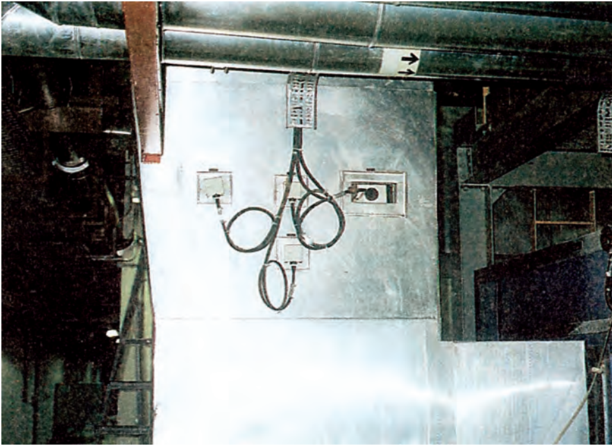
Εικόνα 3.27: Αισθητήρες θερμοκρασίας και υγρασίας, προσαρμοσμένοι πάνω στον κύριο αγωγό στην ΚΚΜ, για να καταγράφει και να παρέχει δεδομένα στο σύστημα ελέγχου.
