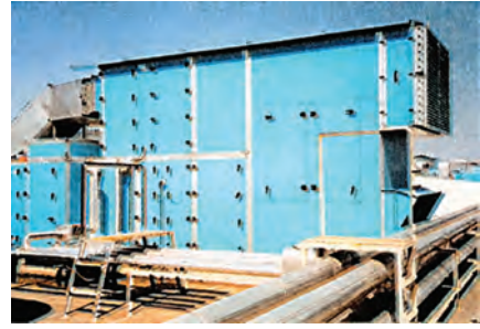
Εικόνα 1.9: Κεντρικές κλιματιστικές μονάδες (ΚΚΜ). Δυο μικρού μεγέθους ΚΚΜ (αριστερά) με είσοδο και παροχή 100% εξωτερικού αέρα και μεγάλου μεγέθους ΚΚΜ (δεξιά) με μείξη εξωτερικού αέρα και αέρα επιστροφής.
