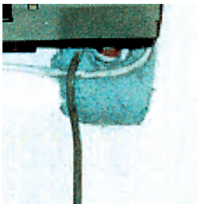
Εικόνα 3.18: Σφράγισμα της τρύπας, απ' όπου περνούν οι σωλήνες του ψυκτικού, με ελαφροτσιμέντο. (Το άσπρο καλώδιο είναι για την ηλεκτροδότηση της μονάδας, ενώ το σκουρόχρωμο είναι του ενσύρματου τηλεχειριστηρίου).
