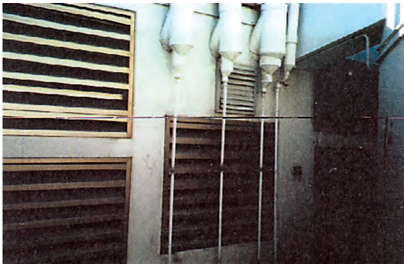
Εικόνα 3.28: Αυτοματοποιημένη ρύθμιση των ντάμπερ του απορριπτόμενου αέρα στο εξωτερικό περιβάλλον.
