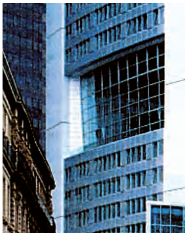
Εικόνα 1.16: Μερική όψη του κτιρίου.
