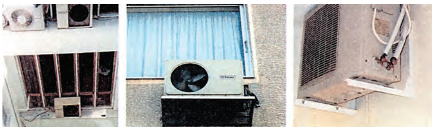
Εικόνα 3.11: Διάφοροι τρόποι τοποθέτησης εξωτερικών μονάδων σε φωταγωγό επί του δαπέδου (αριστερά) και σε εξωτερικούς τοίχους, είτε σε βάση στήριξης (κέντρο), είτε σε μεταλλικές γωνίες (δεξιά).
