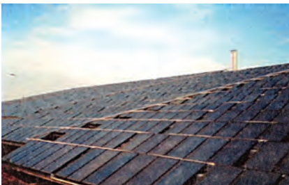
Εικόνα 1.10: Πεδίο επίπεδων ηλιακών συλλεκτών (αριστερά) και ηλιακοί ψύκτες (δεξιά) για τον κλιματισμό των αποθηκευτικών χώρων για τα προϊόντα μιας βιομηχανίας καλλυντικών.
