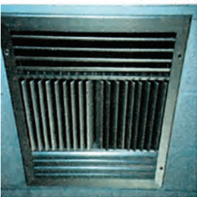
Ορθογωνικό στόμιο οροφής, με ρυθμιζόμενα πτερύγια
