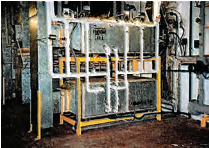
Εικόνα 1.9: Κεντρικές κλιματιστικές μονάδες (ΚΚΜ). Δυο μικρού μεγέθους ΚΚΜ (αριστερά) με είσοδο και παροχή 100% εξωτερικού αέρα και μεγάλου μεγέθους ΚΚΜ (δεξιά) με μείξη εξωτερικού αέρα και αέρα επιστροφής.
