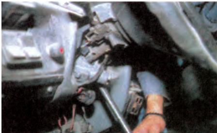
Αφαίρεση της βάσης του άξονα του τιμονιού
