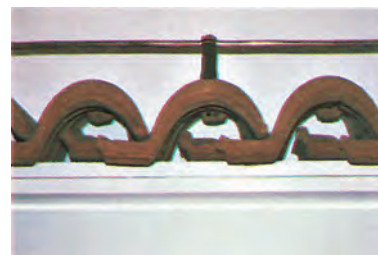
Λεπτομέρεια στήριξης αγωγού στη στέγη
