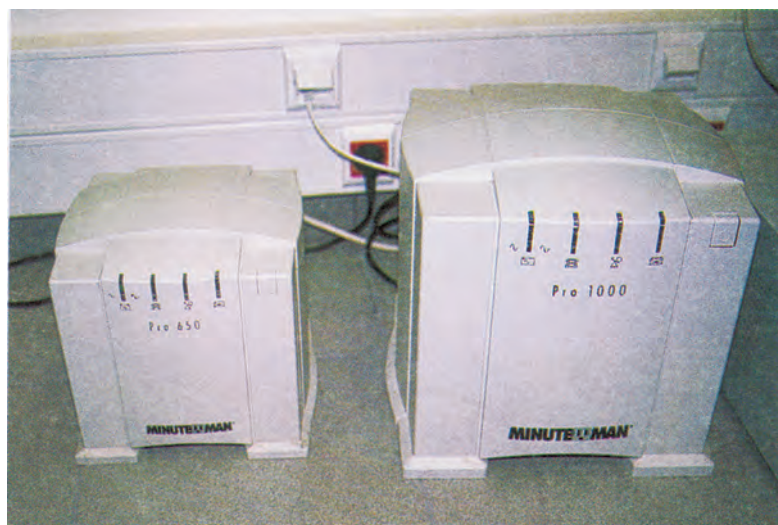
U.P.S. για την τροφοδότηση της εγκατάστασης της δομημένης καλωδίωσης
