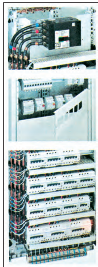
Συναρμολόγηση πίνακα κίνησης
