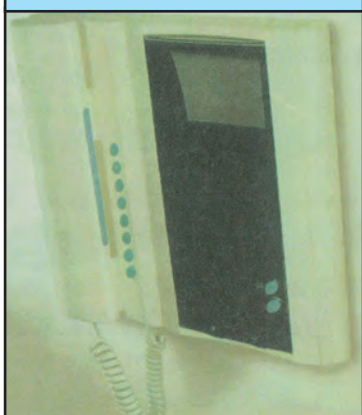
Εικόνα 10.4β: Εσωτερικό στοιχείο
