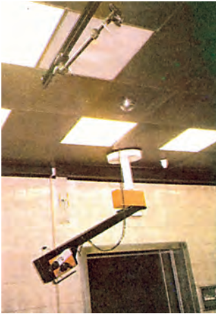
Εικ. 4. Οροφή χειρ/κής αίθουσας. Διακρίνεται ο «σιδηρόδρομος» για να «κυλούν» διάφοροι μηχανισμοί και ο βραχίονας διαθερμίας με τη βιντεοκάμερα.
