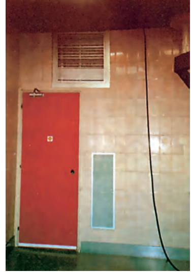
Εικ. 5. Είσοδος από την οροφή και έξοδος σε ύψος 30 εκ. από το δάπεδο του ανακυκλούμενου αέρα στο σύστημα φιλτραρισμένου αέρα θετικής πίεσης.
