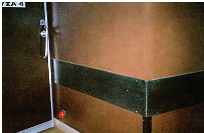
Εικ. 1. – Ανοξείδωτη μεταλλική επένδυση των τοίχων στο ύψος των φορέων και των γωνιών που εξέχουν. – Ποδοδιακόπτης για το άνοιγμα των χειρ/κών αιθουσών από «αποστειρωμένους» χρήστες.
