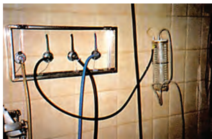
Εικ. 12γ. Επιτοίχιες σωληνώσεις αναισθητικών αερίων σε χειρουργείο με κεντρική εγκατάσταση χορήγησής των.
