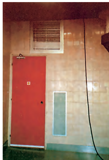
Εικ. 5. Είσοδος από την οροφή και έξοδος σε ύψος 30 εκ. από το δάπεδο του ανακυκλούμενου αέρα στο σύστημα φιλτραρισμένου αέρα θετικής πίεσης.
