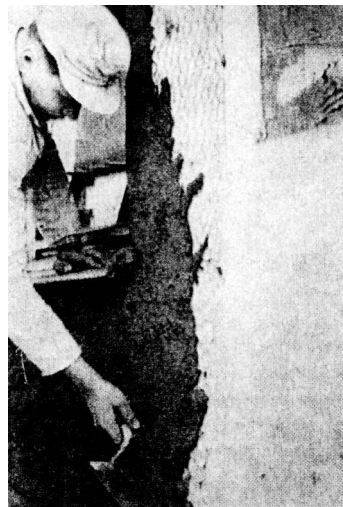
Εικ. 211 Εφαρμογή θερμομονωτικού σοβά.
