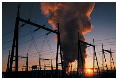
Θερμοηλεκτρικό εργοστάσιο παραγωγής ενέργειας
