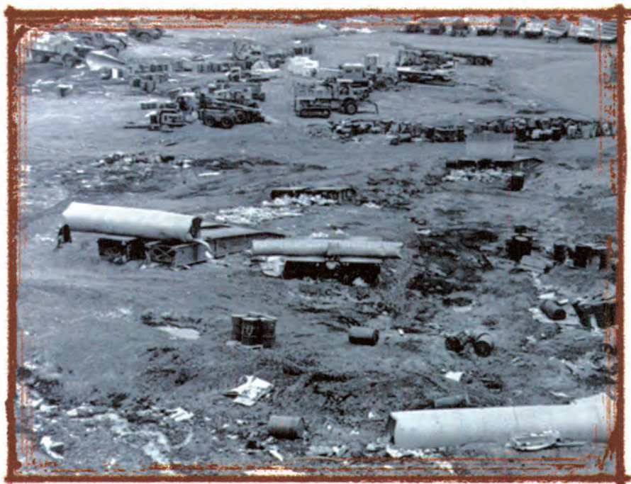
Εικόνα 68 Αυθαιρεσία και εγκατάλειψη. {26}
