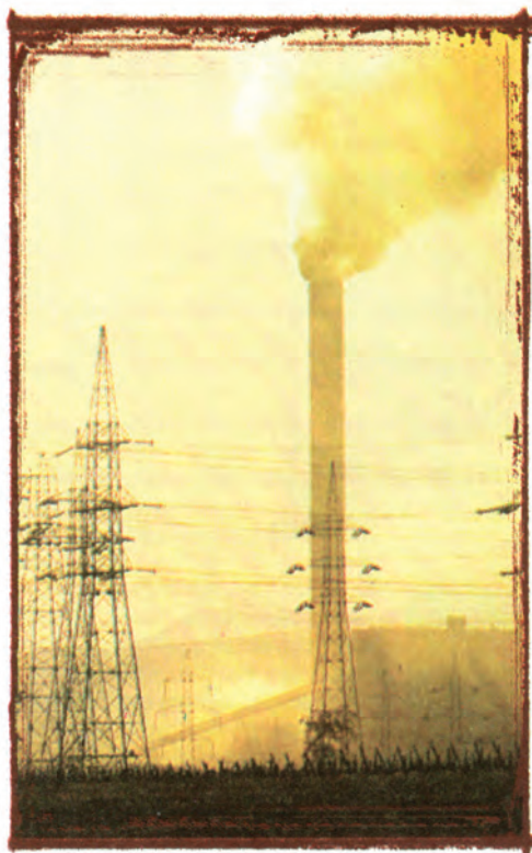
Εικόνα 60 Σταθμός παραγωγής ηλεκτρικής ενέργειας της ΔΕΗ {27}
