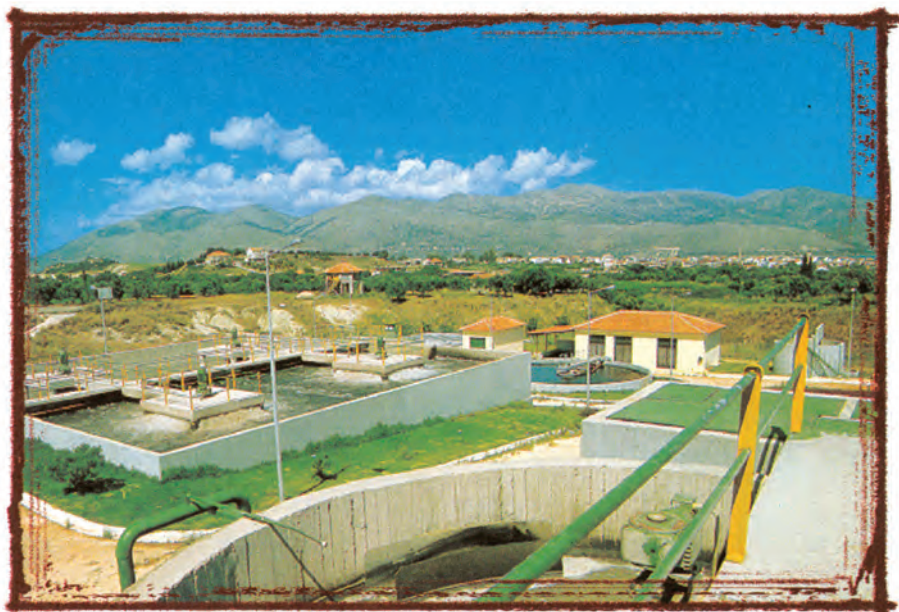
Εικόνα 98 Άποψη βιολογικού καθαρισμού
