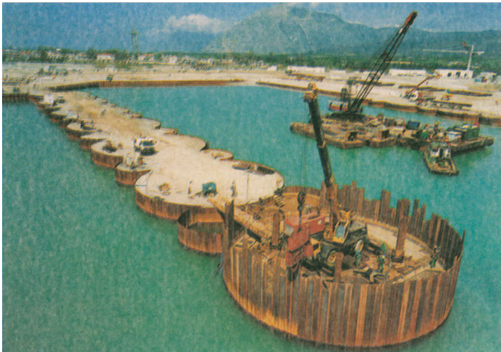
Εργασίες κατασκευής γέφυρας Ρίου-Αντιρρίου
