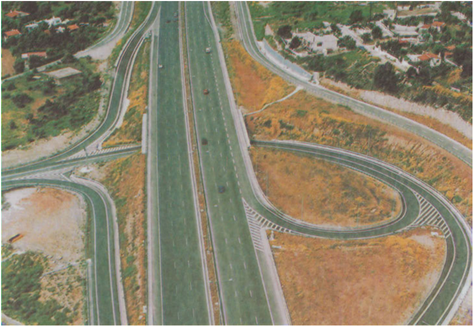
Ανισόπεδος κόμβος στην Π.Α.Θ.Ε.
