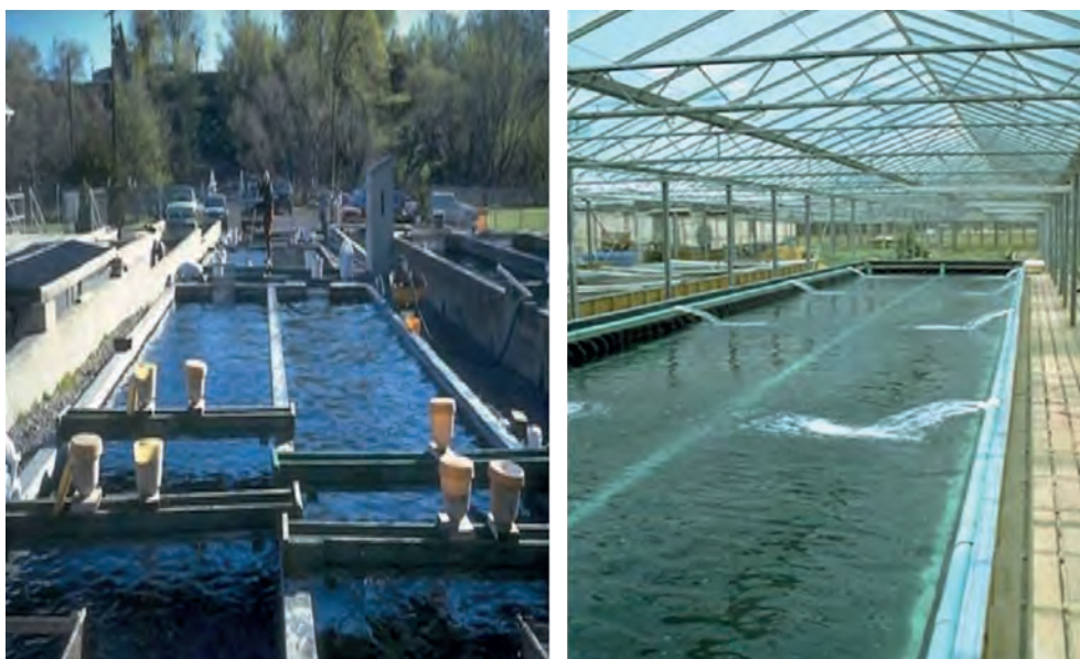
Εικόνα 2.1. Στις τσιμεντένιες δεξαμενές εκτροφής φαίνεται η διαφορά στο χρώμα του περιεχόμενου νερού, που οφείλεται κατά κύριο λόγο στο χρώμα του ουρανού που αντανακλάται στην επιφάνεια του νερού των δεξαμενών.
