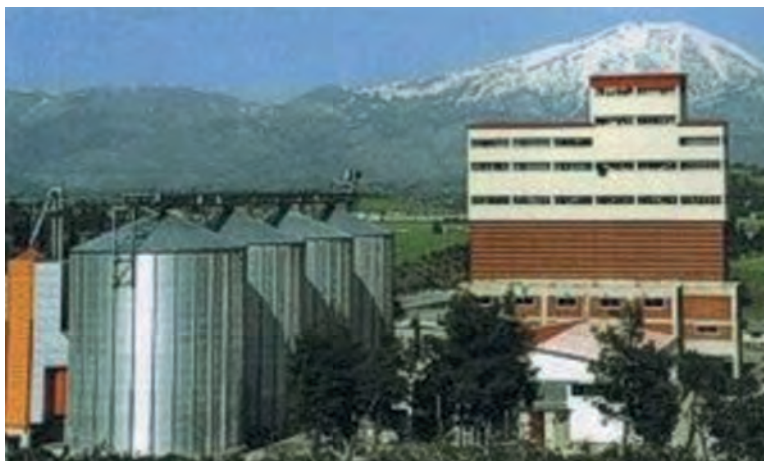
Εικόνα 12.5. Εργοστάσιο ιχθυοτροφών. Διακρίνονται τα σιλό αποθήκευσης πρώτων υλών και το κυρίως κτήριο όπου στεγάζονται οι μηχανές παραγωγής των ιχθυοτροφών.
