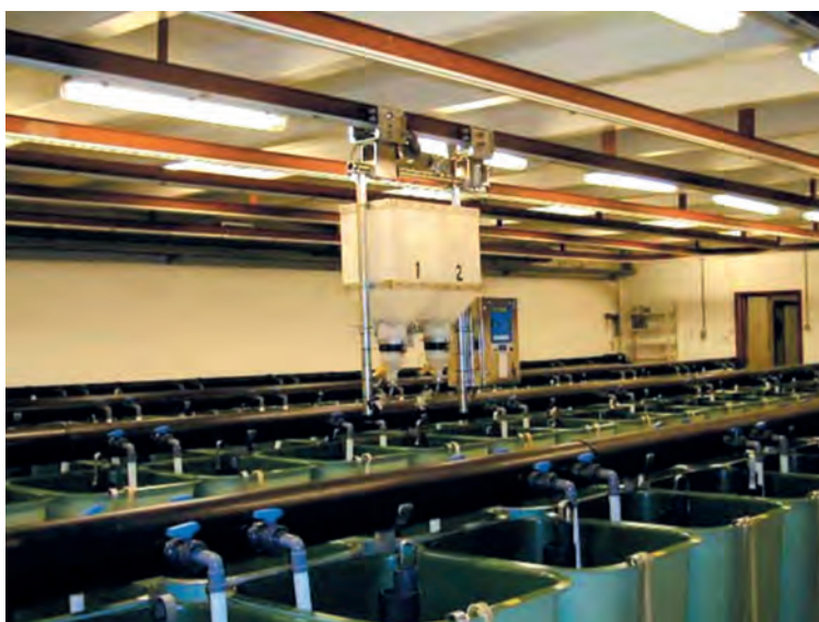
Εικόνα 8.4. Συστοιχία δεξαμενών εκτροφής νυμφών κεφάλου με σύστημα αυτόματης προσφοράς τροφής.
