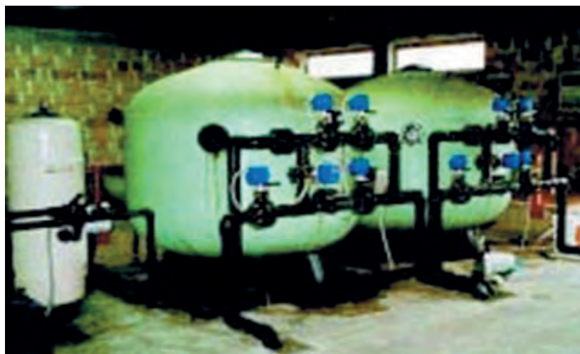
Εικόνα 3.17. Μηχανικό φίλτρο άμμου. Το εξωτερικό περίβλημα είναι από υαλορρητίνη και στο εσωτερικό του υπάρχει η άμμος που αυτοκαθαρίζεται με ανάστροφη ροή του νερού.
