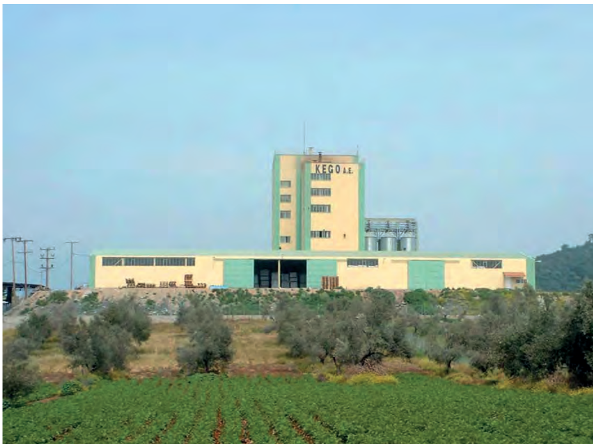
Εικόνα 13.4. Σύγχρονο εργοστάσιο ιχθυοτροφών στην Ν. Αρτάκη Χαλκίδας (KEGO Α.Ε.).
