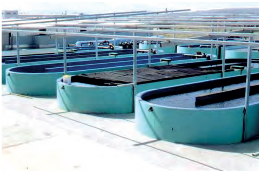
Εικόνα 3.16. Τσιμεντένιες ελλειψοειδείς δεξαμενές σε ιχθυογεννητικό σταθμό. Διακρίνεται το ενδιάμεσο διαχωριστικό διάφραγμα.
