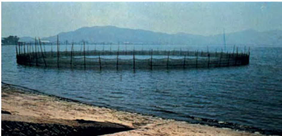
Εικόνα 3.3. Περίκλειστο. Διακρίνονται οι πάσσαλοι που είναι μπηγμένοι στο θαλάσσιο πυθμένα (βενθικό υπόστρωμα) και το δίχτυ που στερεώνεται σε αυτούς.
