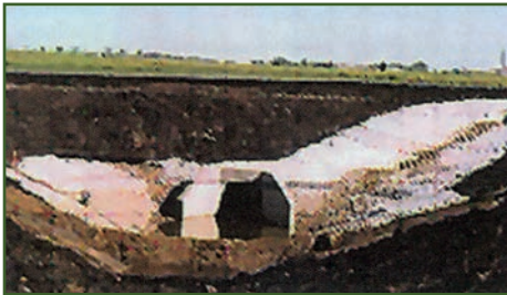
Εικόνα 5.18: Εφαρμογή γεωυφάσματος σε αποχετευτικό έργο
