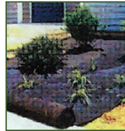
Εικόνα 5.19: Μη υφάνσιμα χρησιμοποιούμενα για τη διατήρηση της υγρασίας του εδαφικού υποστρώματος
