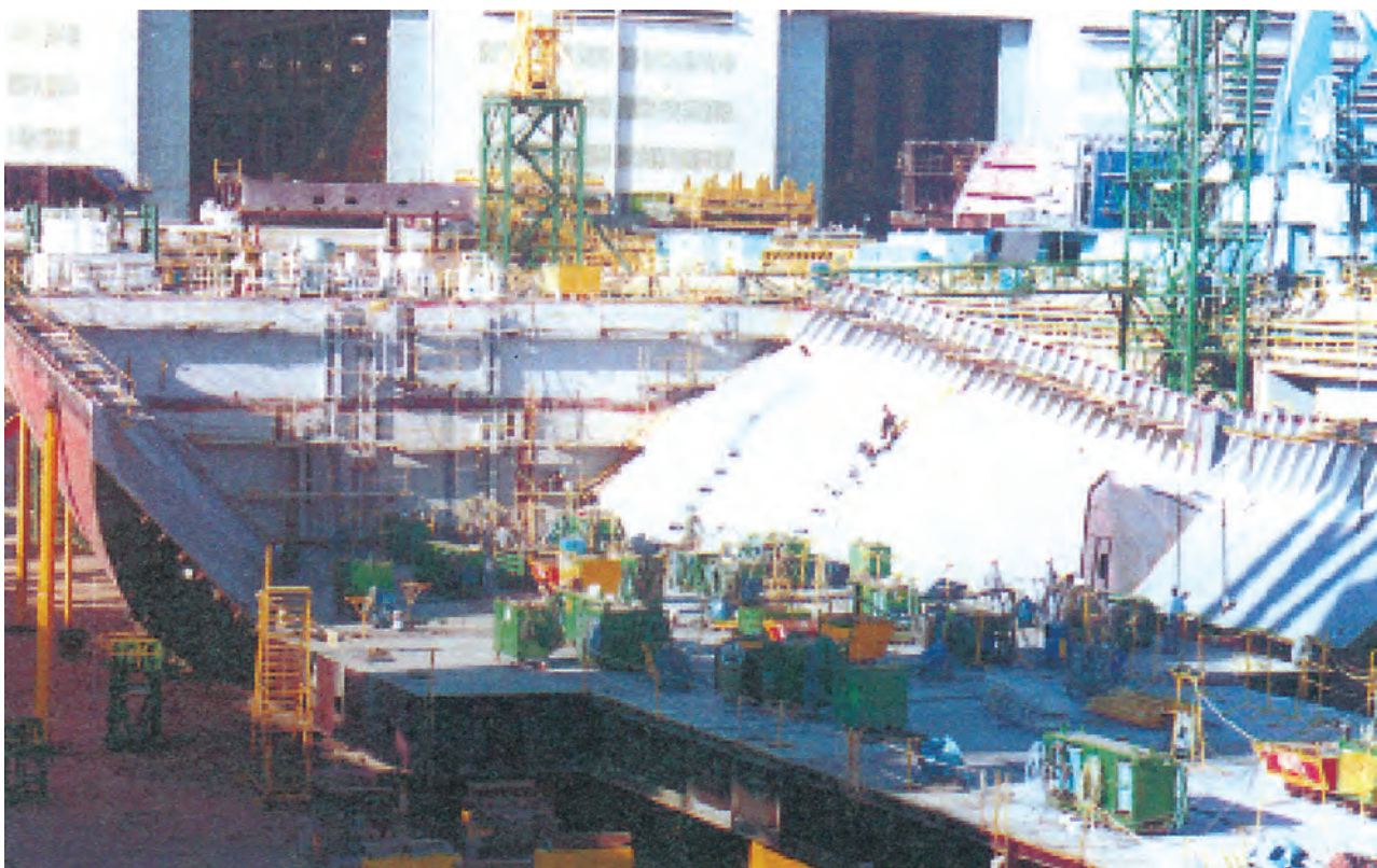
Φωτ. 9.2 Αρχικά στάδια κατασκευής - Διπύθμενα πλοίου
