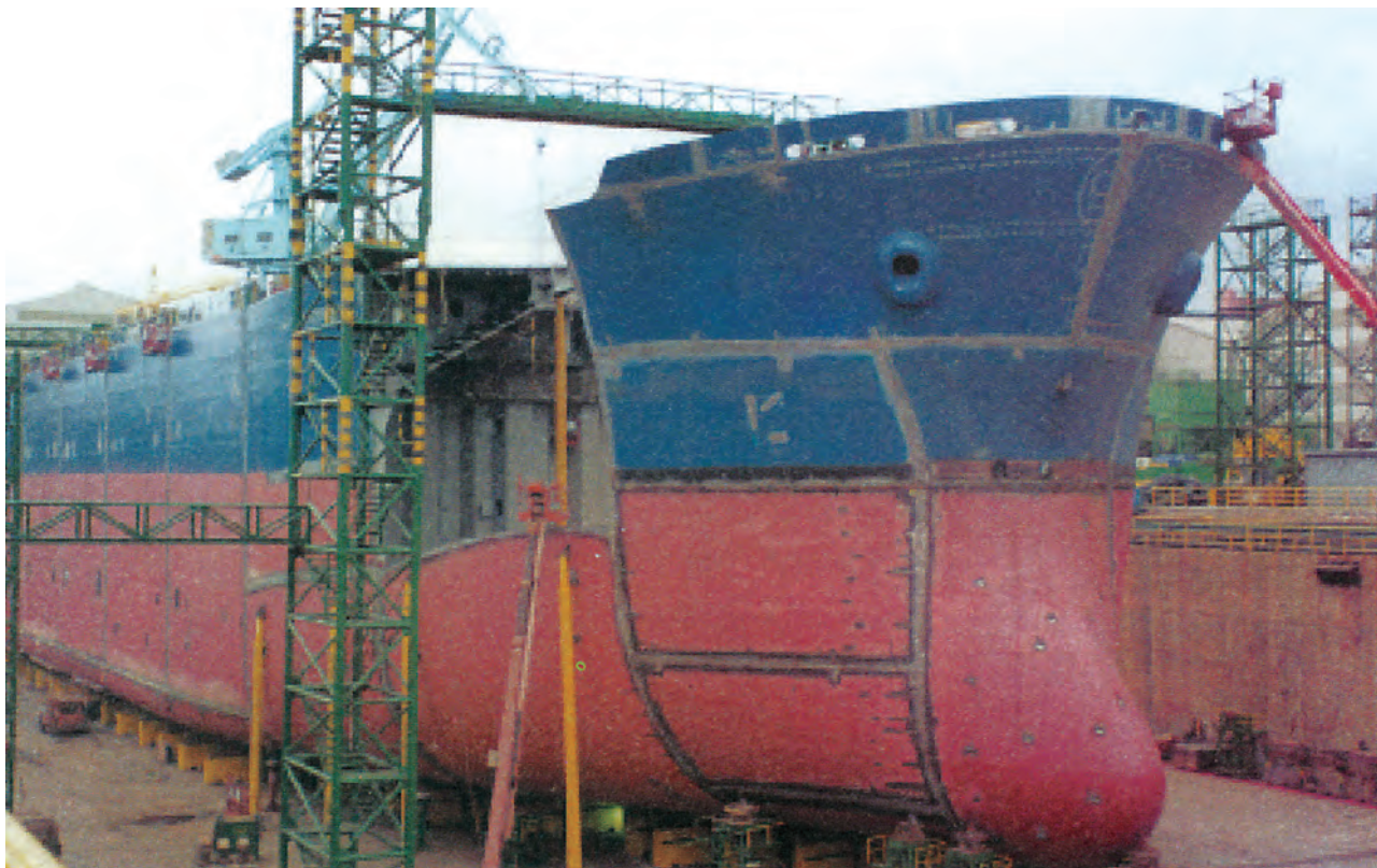
Φωτ. 9.5 Τοποθέτηση προωραίου block
