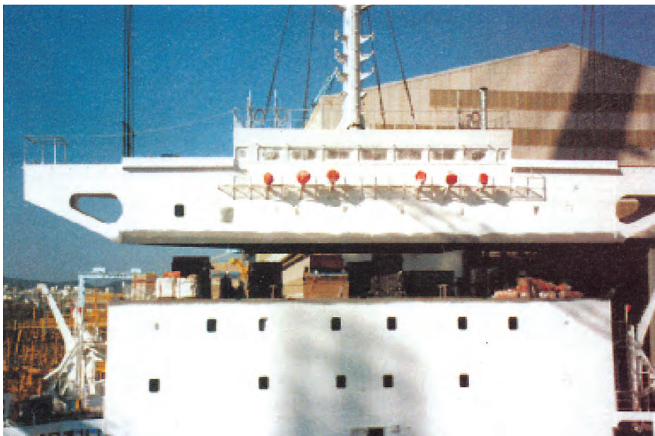
Φωτ. 9.6 Τοποθέτηση γέφυρας
