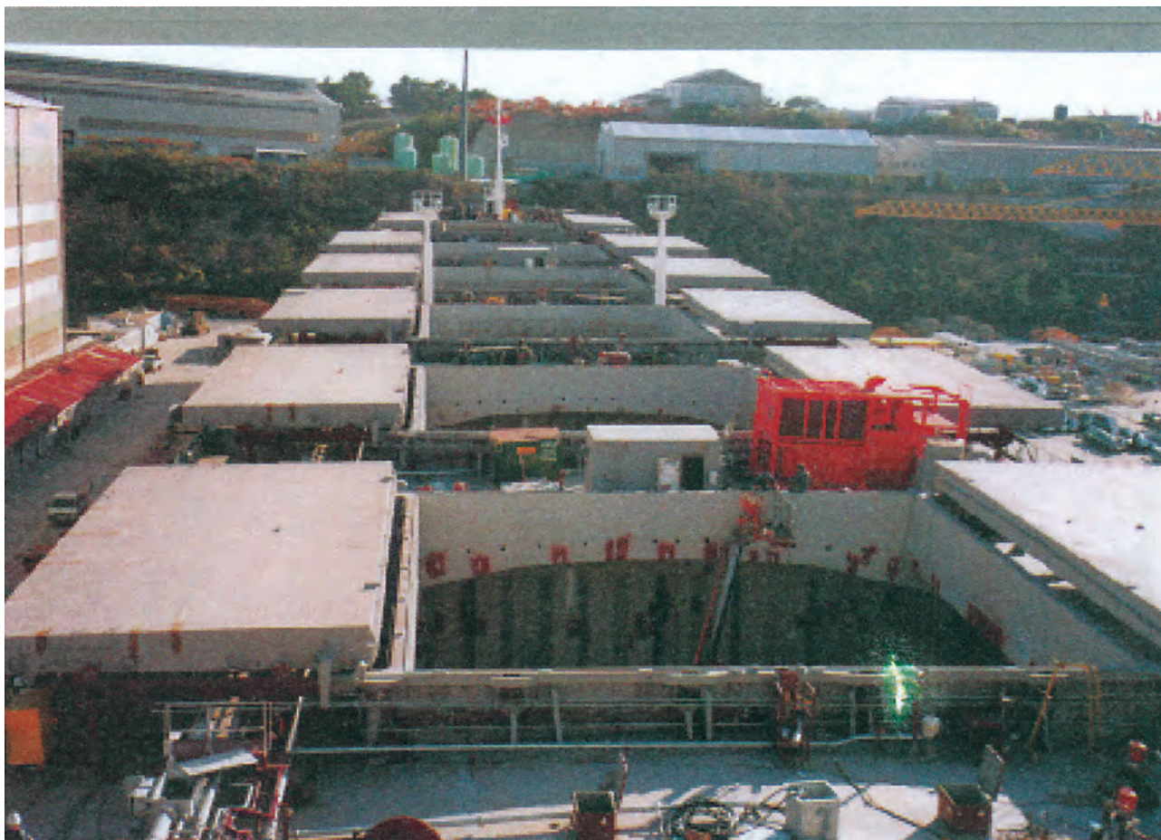
Φωτ. 9.7 Ανοίγματα καταστώματος
