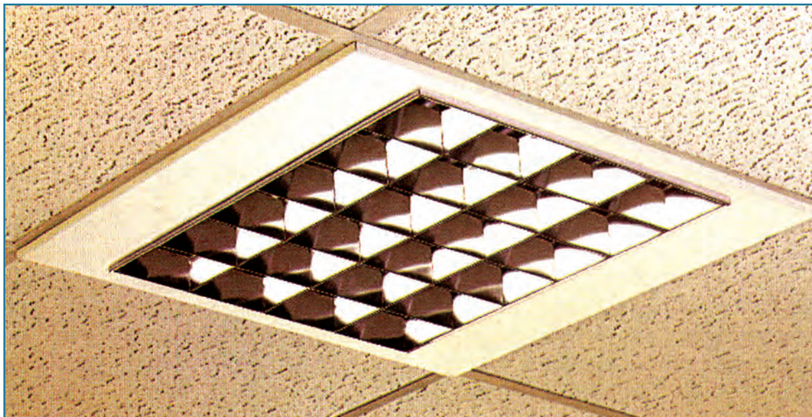
Σχήμα 4.6: Φωτιστικό σώμα με περσίδες
