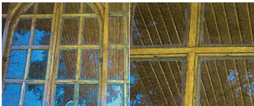
Εικ. 4.53. Παράθυρο με καΐτια (αριστερά). Λεπτομέρεια κατασκευής καΐτιού (δεξιά). Διακρίνονται τα πηχάκια στήριξης των τζαμιών.
