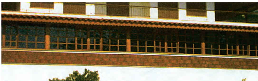
Εικ. 4.52. Κατασκευή ναλοστασίου με καΐτια.
