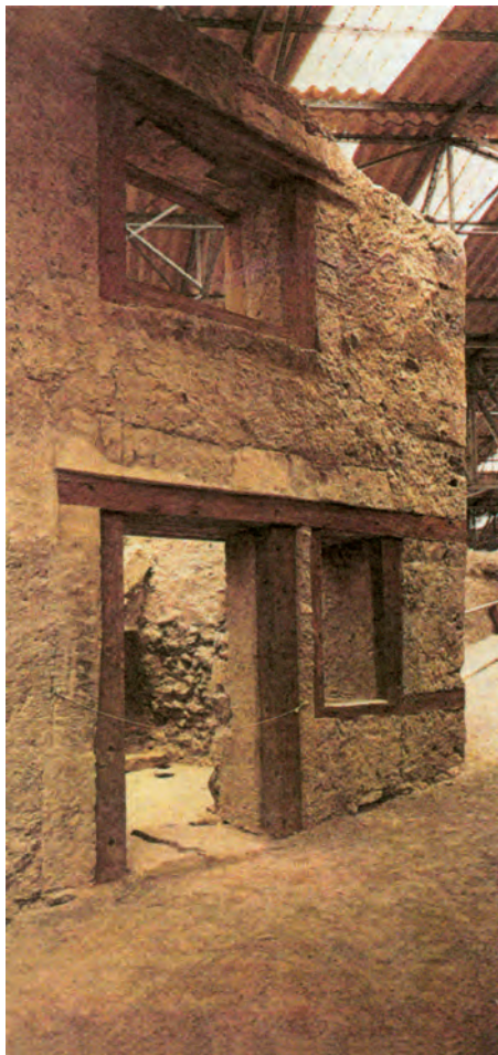
Εικ.6.10: Ακρωτήρι Θήρας. Παρατηρούνται τα εκμαγεία των θυρών και των παραθύρων με όλες τις λεπτομέρειες του ξύλου.
