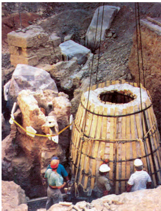
Εικ.3.17: Αποθηκευτικός σιρός από την ανασκαφή που πραγματοποιήθηκε στο σταθμό του Συντάγματος του ΜΕΤΡΟ Αθηνών επί της λεωφόρου Αμαλίας, μετά τη λήψη των πρώτων σωστικών μέτρων για την ασφαλή απομάκρυνσή του
