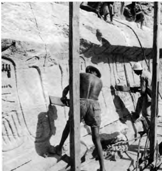
Εικ.5.11: Ορισμένα σημεία των ναών στο Αμπού Σιμπέλ τεμαχίστηκαν με τη χρησιμοποίηση μεγάλων χειροκίνητων ατσάλινων πριονιών.
