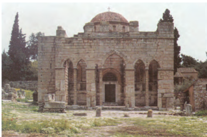
Εικ.1.19: Στη δυτική όψη της Μονής Δαφνίου είναι εμφανή τα οξυκόρυφα γοτθικά τόξα φραγκικής προέλευσης, τα οποία συνυπάρχουν με το βυζαντινής προέλευσης τρούλο του καθολικού. Ο συνδυασμός αυτός συμβάλλει - μεταξύ άλλων - στην "ιστορικότητα" του μνημείου.
