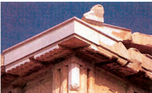
Εικ. 6.21: Λεπτομέρεια από τη νότια γωνία του ανατολικού αετώματος του Παρθενώνα όπου διακρίνονται τα συμπληρωμένα τμήματα με νέο μάρμαρο
