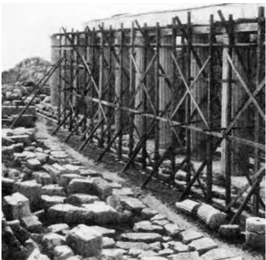
Εικ.6.23: Στο μνημείο του Επικούριου Απόλλωνα στις Βάσσες φαίνονται οι πρώτες κατασκευές αντισεισμικής προστασίας (1969-1972).
