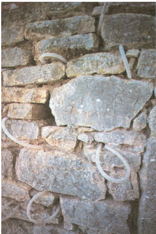
Εικ.1.16: Ενίσχυση εσωτερικού λιθοδομής με τη χρήση ενεμάτων
