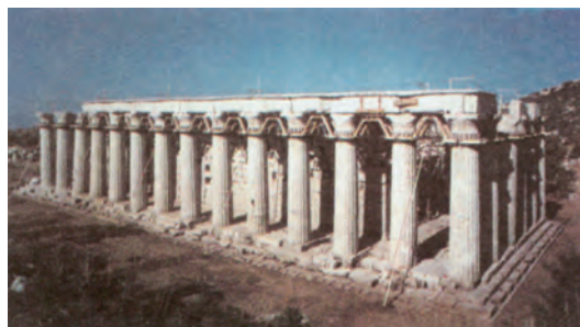
Εικ. 6.24: Ο ναός του Επικούριου Απόλλωνα στις Βάσσεις μετά τις πρόσφατες αντισεισμικές και αντικεραυνικές κατασκευές (1984 - 1986).
