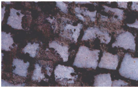
Τμήμα ψηφιδωτού όπου οι ψηφίδες και το κονίαμα έχουν καλυφθεί με λειχήνες.
