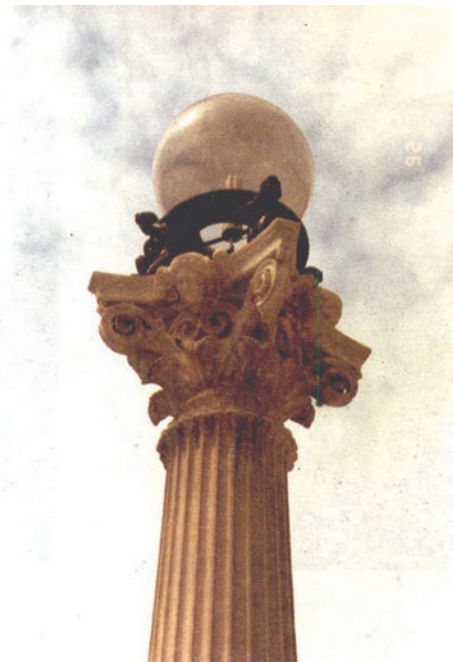
Διαδικασία καθαρισμού και συμπλήρωσης (με κονίαμα) μαρμάρινου γλυπτού διάκοσμου. Ακαδημία Αθηνών.
