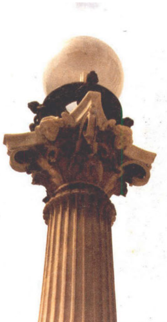
Διαδικασία καθαρισμού και συμπλήρωσης (με κονίαμα) μαρμάρινου γλυπτού διάκοσμου. Ακαδημία Αθηνών.
