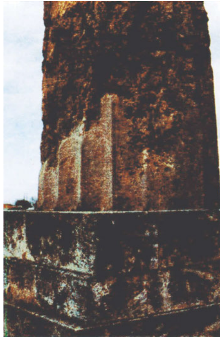
Συμπλήρωση βάσης κίονος, για στατικούς λόγους, του αρχαϊκού ναού του Απόλλωνα στην Αρχαία Κόρινθο.
