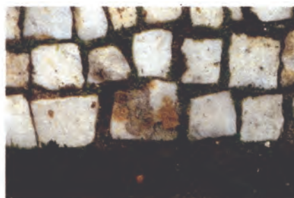
Διάβρωση των ψηφιδωτών από βρύα.
