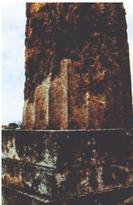
Συμπλήρωση βάσης κίονος, για στατικούς λόγους, του αρχαϊκού ναού του Απόλλωνα στην Αρχαία Κόρινθο.
