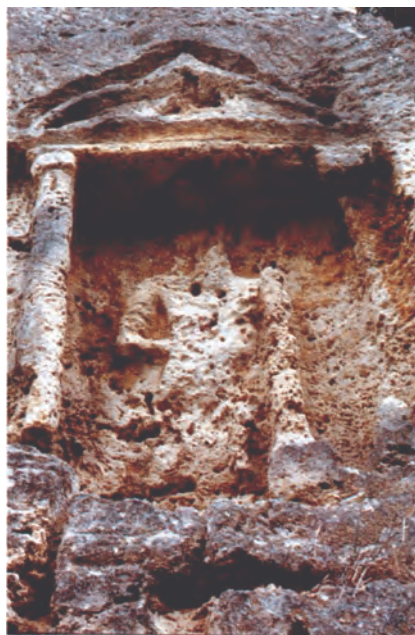
Διάβρωση από διαλυτά άλατα. Ανάγλυφη προτομή εποχής Νέρωνα στον Ισθμό της Κορίνθου.
