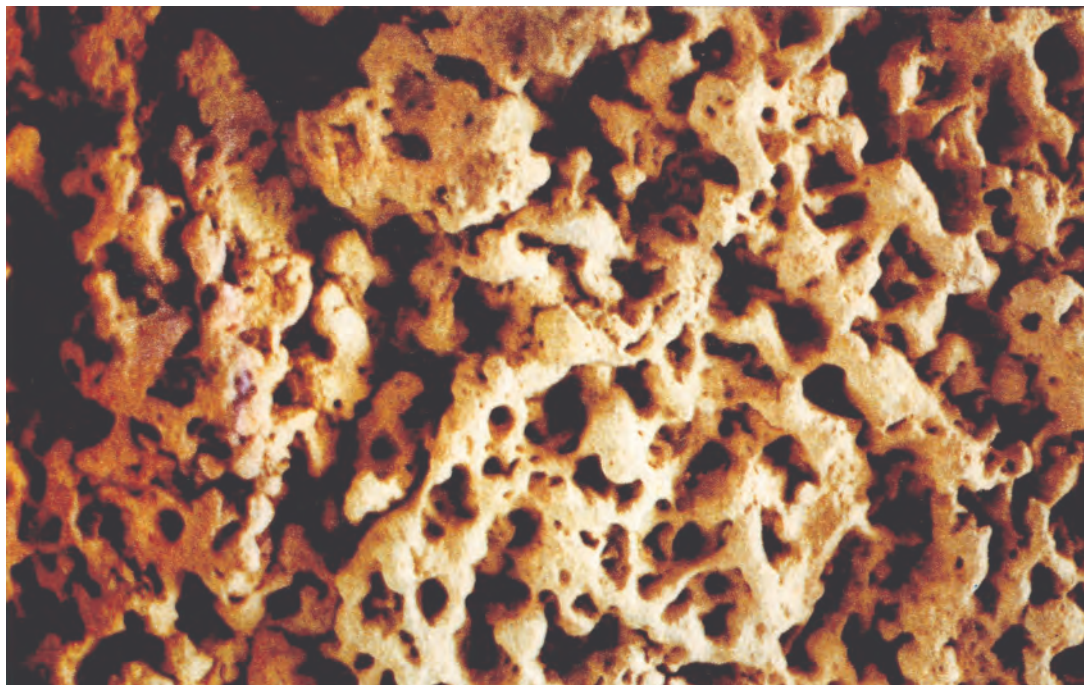
Κυψέλωση ασβεστιτικού πωρόλιθου από την πάροδο του θεάτρου της Αρχαίας Σικυώνος.
