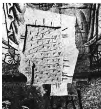
Τοποθέτηση κονιάματος στον τοίχο.
