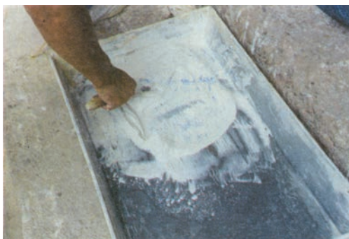
Προετοιμασία ασβεστοκονιόματος
