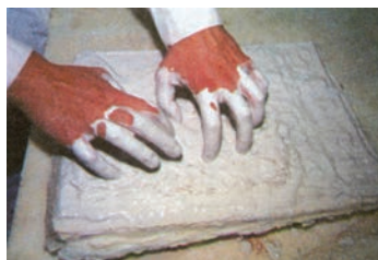
Τοποθέτηση της τζίβας με γύψο πάνω στο πρώτο λεπτό στρώμα.
