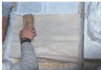
Τοποθέτηση και επικόλληση του 2ου πανιού.
