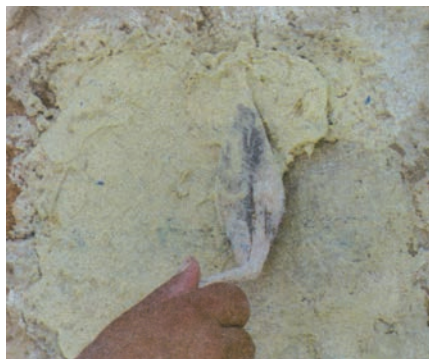
Πέρασμα με το μυστρί του ασβεστοκονιάματος
