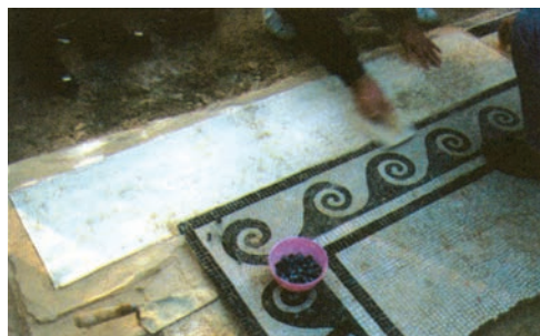
Διαδικασία τοποθέτησης ψηφιδωτού στο δάπεδο.
