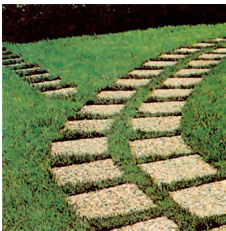
γ.12 Πλακίδια ψηφίδων με τραχιά επιφάνεια σχηματίζουν διάδρομο και μικρή σκάλα στο γρασίδι.
