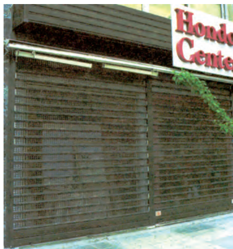
β.124 Ρολά από διάτρητη λαμαρίνα με μεγάλα κενά για την άνετη παρατήρηση της βιτρίνας.
