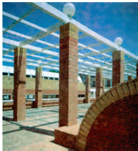
γ.20 Πέργκολα με στηρίγματα από τούβλα και πλέγμα από μπετόν, στοιχεία που δανείζεται από το δυπλανό στεγασμένο χώρο.
