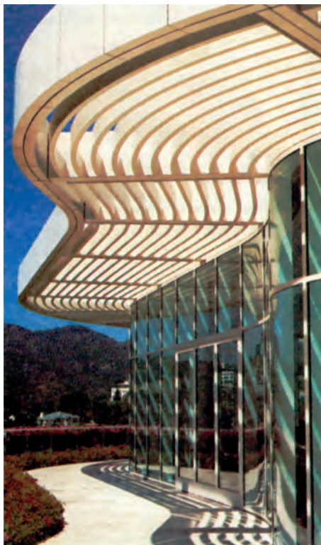
Β.117 Σταθερή κατασκευή σε στέγαστρο το οποίο κατασκευάστηκε ταυτόχρονα με το κτίριο.
