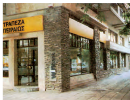
β.136 Η επένδυση των υποστυλωμάτων με σχιστόλιθους τονίζει τη θέση τους στην πρόσοψη, δημιουργώντας αντιθέσεις με τα υπόλοιπα υλικά.
