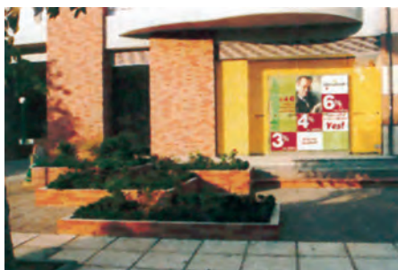
β.128 Επένδυση τμήματος της πρόσοψης με διακοσμητικά τούβλα τα οποία χρησιμοποιούνται και για την κατασκευή των παρτεριών.
