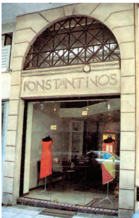
β.114 Οι γραμμικές χαράξεις στο πλαίσιο της πρόσοψης εφαρμόζονται και στην επιγραφή, διαμορφώνοντας έτσι τα γράμματα στο όνομα του καταστήματος.
