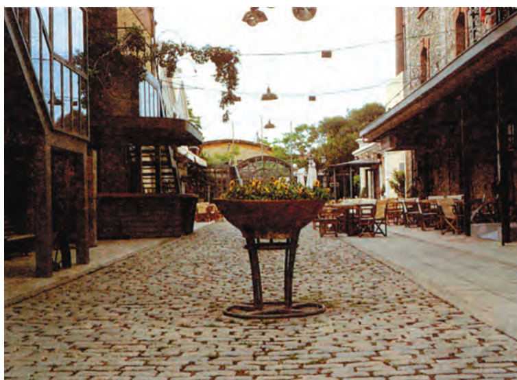
γ.6 Γρανιτένιοι κυβόλιθοι σε διάδρομο που διατρέχει τον εξωτερικό χώρο συγκροτήματος.
