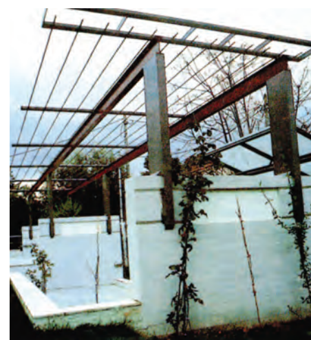
γ.19 Πέργκολα από χτιστά στηρίγματα και μεταλλικό πλέγμα. Διακρίνονται τα σύρματα για την αναρρίχηση των φυτών και οι συμπαγείς χαμηλοί τοίχοι, που δίνουν μια αίσθηση ιδιωτικότητας στο καθιστικό.
