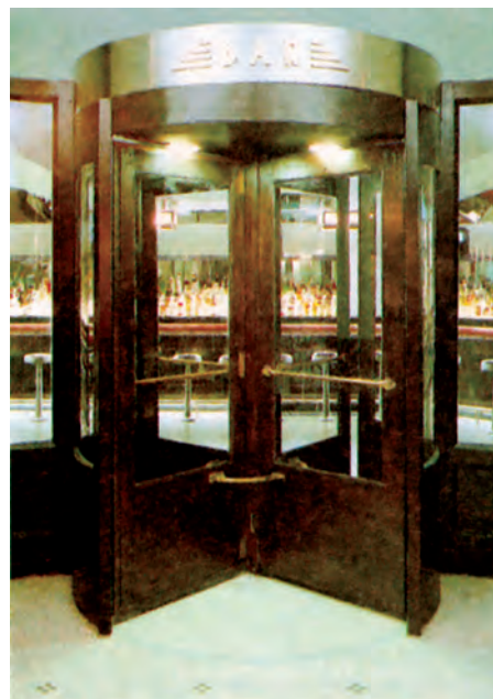
β.98 Περιστρεφόμενη πόρτα τύπου «βαρέλι» σε διαφανή πρόσοψη.
