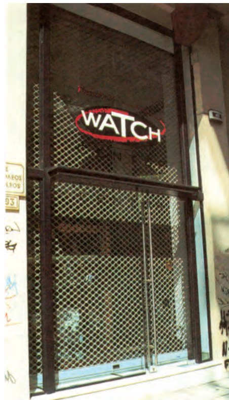
β.122 Η πιο συνηθισμένη μορφή ρολού από μεταλλικό πλέγμα, που διαμορφώνει μεγάλα εξαγωνικά κενά.
