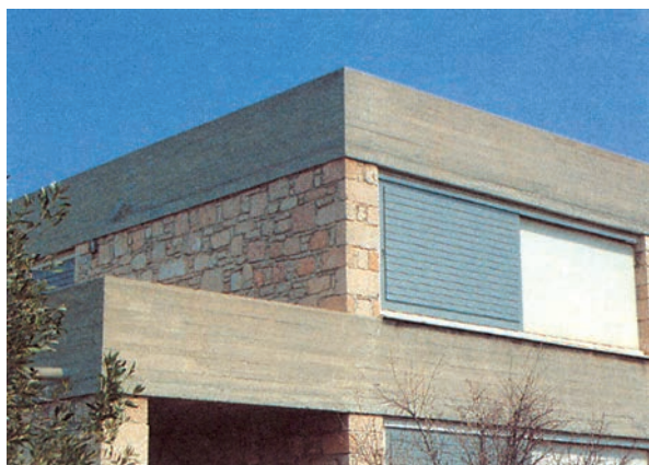
71. Λεπτομέρεια κατοικίας, όπου διακρίνουμε παράθυρο ξύλινο, συρόμενο. Οι τοίχοι είναι από λιθοδομή και από επιχρισμένη οπτοπλινθοδομή (τούβλα). Ο φέρων οργανισμός (υποστυλώματα και δοκάρια) είναι από μπετόν ανεπίχριστο.
