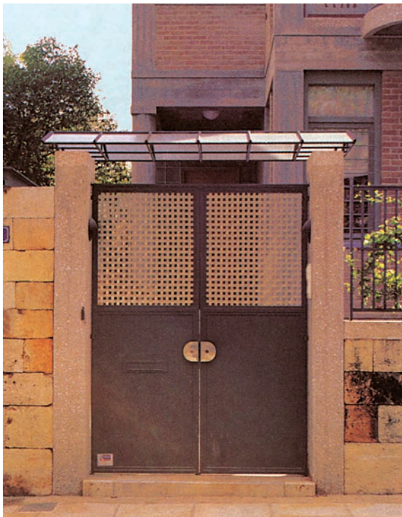
201. Πόρτα αυλής σε κατοικία στη Φιλοθέη.
