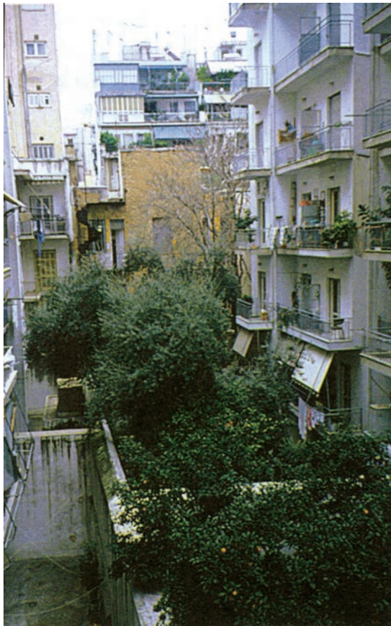
36. Ο ακάλυπτος χώρος της πολυκατοικίας.
