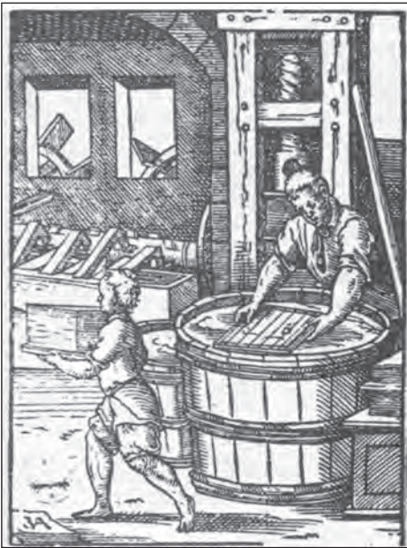
17.4 Διαδικασία κατασκευής χαρτιού: Ο χαρτοπολτός από λινά ράκη απλώνεται πάνω σε συρμάτινο πλέγμα, για να στραγγίσει και να στερεοποιηθεί. Ξυλογραφία 16ου αιώνα.
