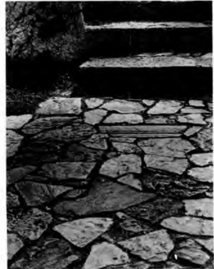
Εικ.3.27 Πλακοστρώση με μη κανονικές πλάκες στη διαμόρφωση γύρω από την Ακρόπολη, έργο του αρχιτέκτονα Δ. Πικιώνη.
