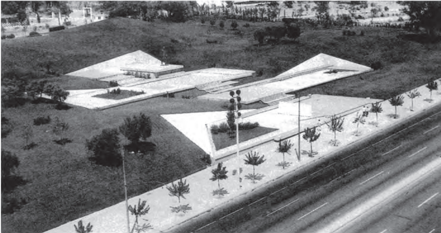
Εικ. 6.20 β Η διαμόρφωση του χώρου που περιβάλλει τον ανδριάντα του Ελ. Βενιζέλου στο πάρκο Ελευθερίας είναι μία τυπικά ασύμμετρη διάταξη. Ο κύριος άξονας της σύνθεσης κατευθύνει προς την κεντρική μορφή. Τα στοιχεία που συνοδεύουν την πορεία αυτή πλέκονται σε ελεύθερες γεωμετρικές μορφές, που παρακολουθούν την κλίση του εδάφους και διαμορφώνουν επίπεδα σε διαφορετικές στάθμες. Υπάρχει ασύμμετρη διάταξη στην επίπεδη και στερεομετρική μορφή της. Οι πλακοστρώσεις ακολουθούν την ελεύθερη αντίληψη της σύνθεσης. Έργο του αρχιτέκτονα Π. Βοκοτόπουλου.
