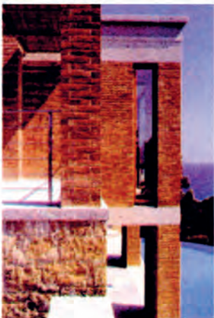
Εικ.5.6 Κατοικία στη Χαλκιδική σχεδιασμένη από τον Κ. Κρόκο. Τα υλικά της κατασκευής, τούβλο, πέτρα, μπετόν, ξύλο, χρησιμοποιούνται με τα φυσικά χρώματά τους.
