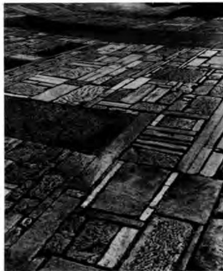
Εικ.3.26 Η πλακοστρώση στην είσοδο της Ακρόπολης, έργο του αρχιτέκτονα Δ. Πικιώνη (1964). Στο έργο συνδυάζονται ορθογωνικές πλάκες μαρμάρου με διάφορες διαστάσεις.
