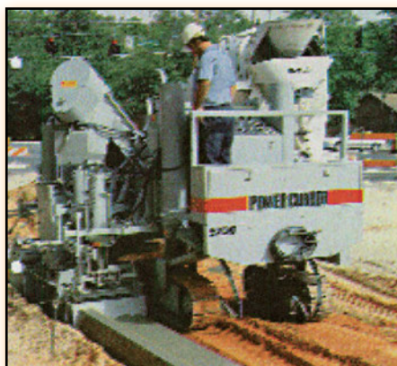
Σχήμα 1.19. Ειδικό μηχάνημα κατασκευής κρυσπέδων οδού
