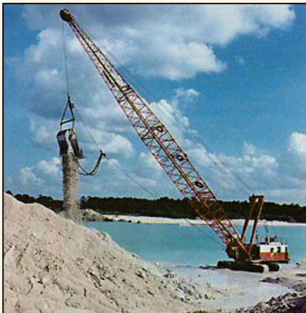
Σχήμα 1.3. Εργοτάξιο λιμενικού έργου (φάση εκβάθυνσης λιμένα)
