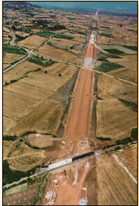
Σχήμα 1.2. Εργοτάξιο οδοποιίας (φάση χωματουργικών)
