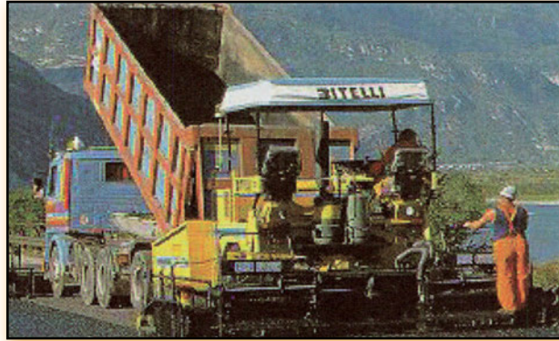
Σχήμα 1.22. Ασφαλτόστρωση οδού
