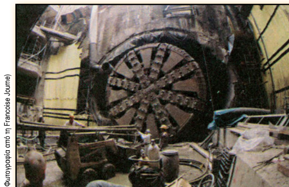
Σχήμα 1.4. Κεφαλή TBM (Μετρό Αθηνών)
