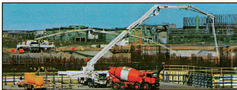
Σχήμα 3.18. Αντλίες σκυροδέματος σε ώρα εργασίας
