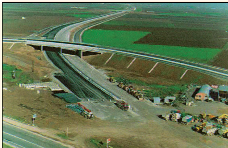
Σχήμα 1.14. Εργοτάξιο Οδοποιίας (έργα ΠΑΘΕ)
