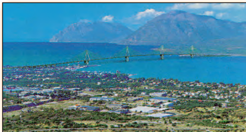
Σχήμα 1.9. Γέφυρα Ρίου - Αντιρρίου
