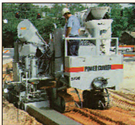
Σχήμα 1.19. Ειδικό μηχάνημα κατασκευής κρασπέδων οδού
