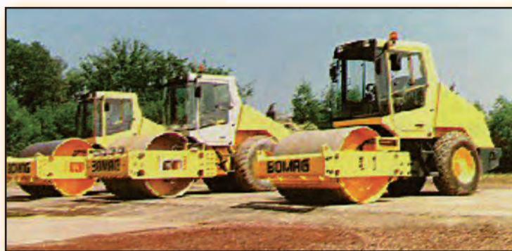
Σχήμα 1.21 Οδοστρωτήρες σε συμπίκνωση βάσης οδού
