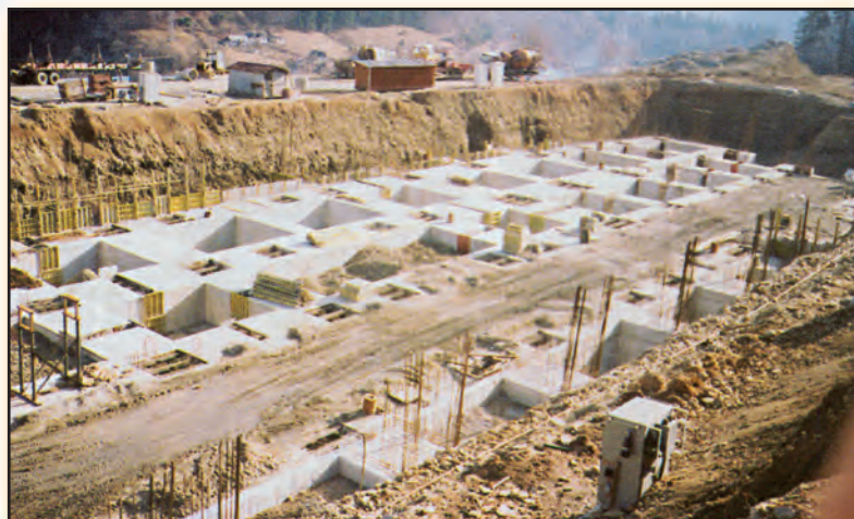
Σχήμα 1.1. Εργοτάξιο οικοδομικού έργου
