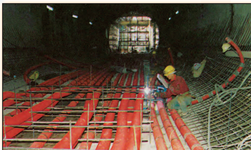
Σχήμα 1.11. Εργασίες στο Μετρό της Αθήνας
