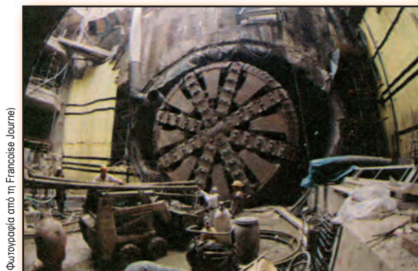
Σχήμα 1.4. Κεφαλή TBM (Μετρό Αθηνών)
