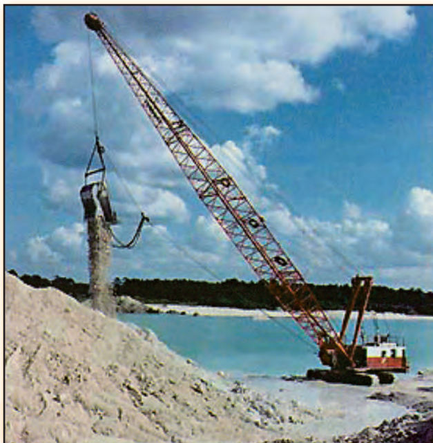
Σχήμα 1.3. Εργοτάξιο λιμενικού έργου (φάση εκβάθυνσης λιμένα)
