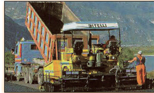
Σχήμα 1.22. Ασφαλτόστρωση οδού
