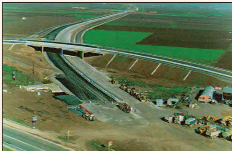
Σχήμα 1.14. Εργοτάξιο Οδοποιίας (έργα ΠΑΘΕ)
