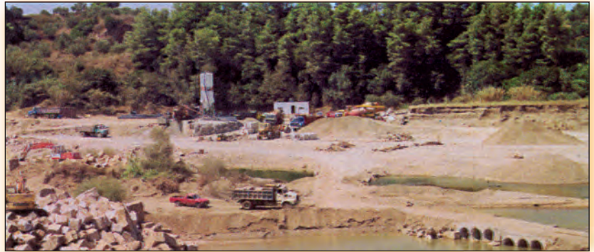
Σχήμα 2.9. Συγκρότημα παραγωγής σκυροδέματος
