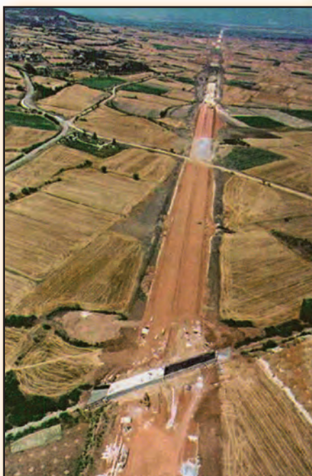
Σχήμα 1.2. Εργοτάξιο οδοποιίας (φάση χωματουργικών)
