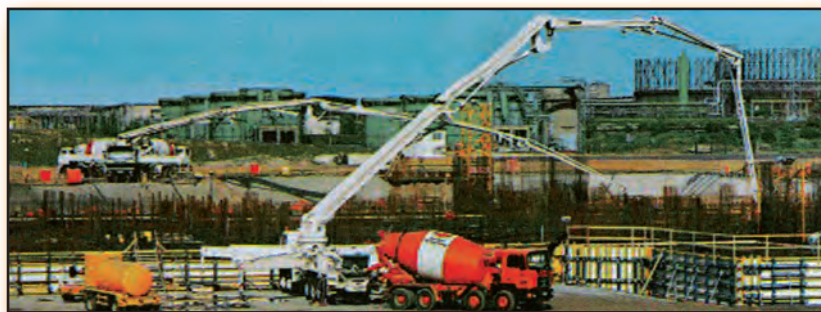
Σχήμα 3.18. Αντλίες σκυροδέματος σε ώρα εργασίας
