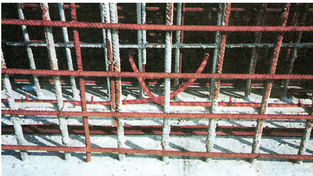
Σχήμα 10.26 Αναμονές οπλισμού μετά τη σκυροδέτηση τοιχίου
