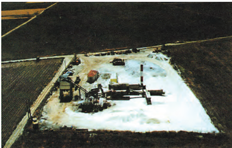
Σχήμα 9.1 Εργοστάσιο παρασκευής ασφαλτοκονιαμάτων
