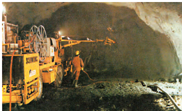
Σχήμα 10.33 Χρήση εκτοξευόμενου σκυροδέματος σε υπόγεια στοά
