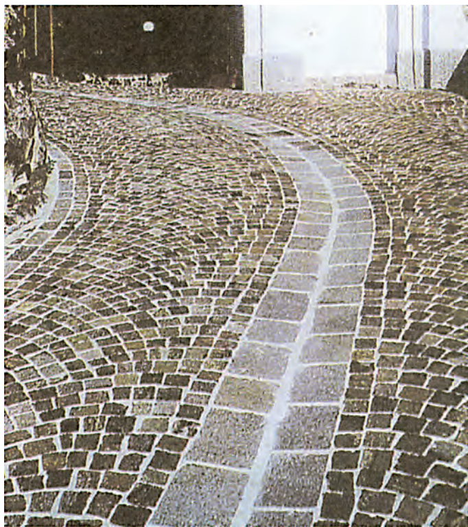
Σχήμα 11.6 Επίστρωση δρόμου με κυβόλιθους
