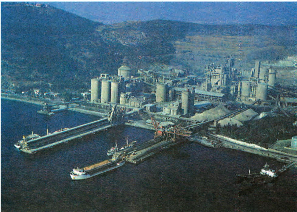
Σχήμα 7.4 Εργοστάσιο παραγωγής τσιμέντου (ΑΓΕΤ-Ηρακλής, Βόλος)
