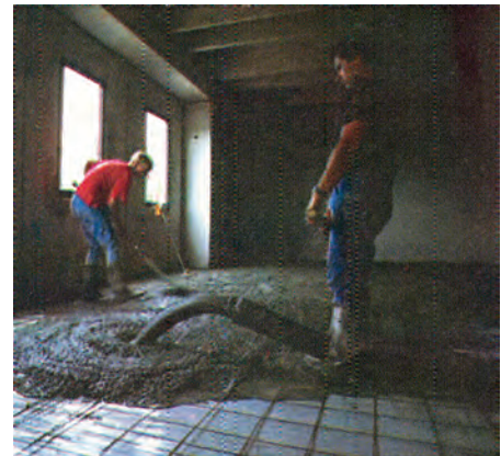
Σχήμα 10.24 Διάστρωση άοπλου σκυροδέματος
