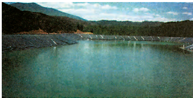
Σχήμα 17.13 Προστασία πρηνών με χρήση υδατομονωτικών
