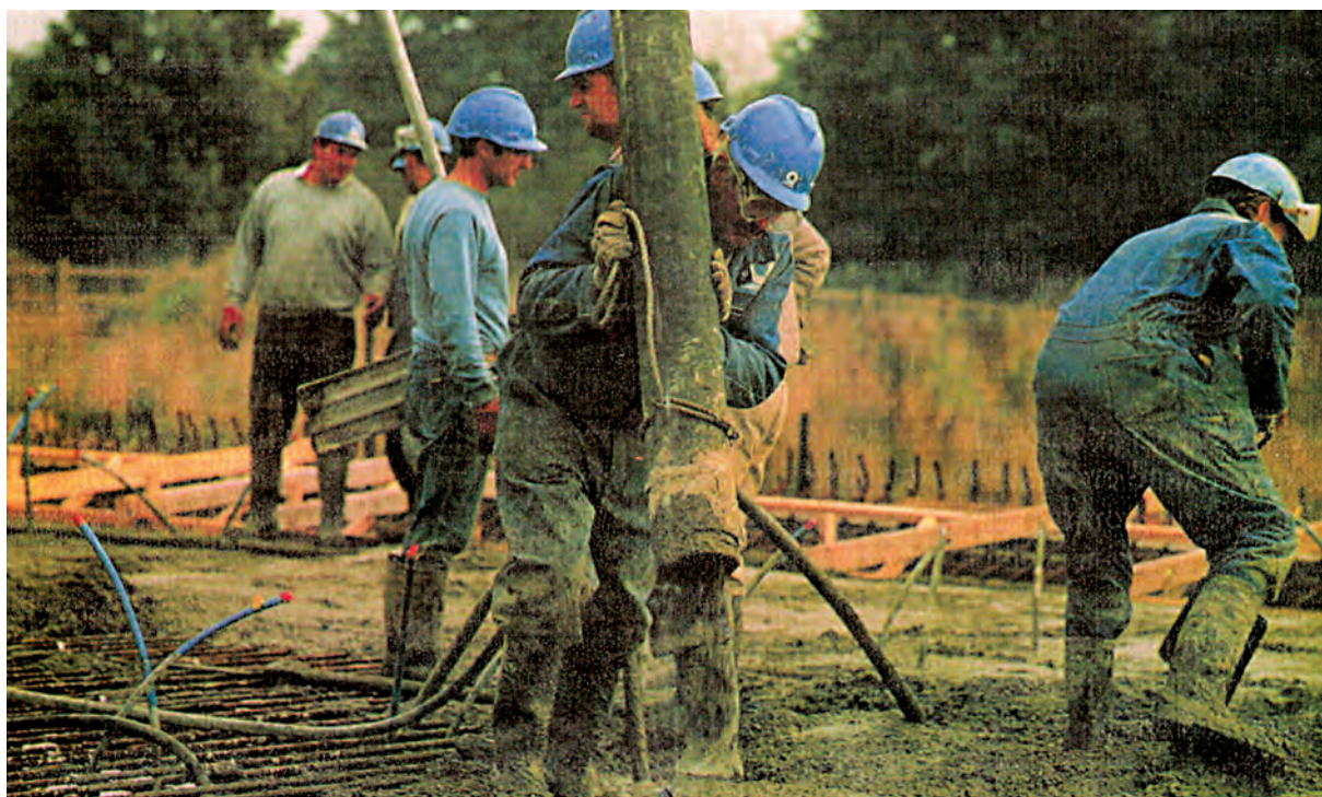
Σχήμα 10.10 Διάστρωση και συμπίκνωση σκυροδέματος σε εργοτάξιο
