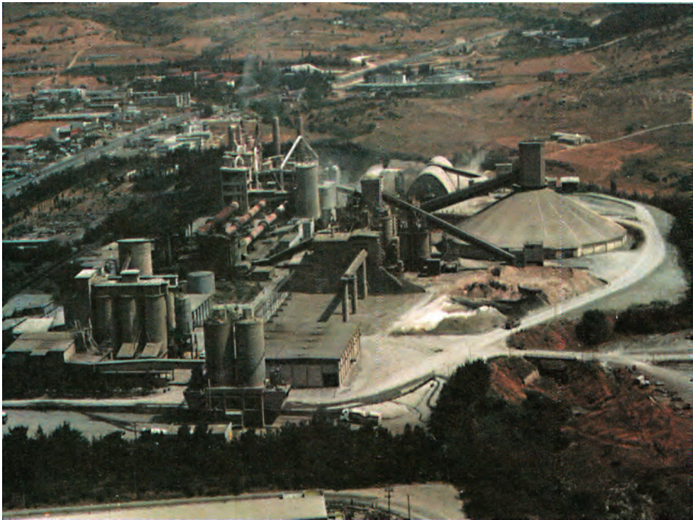
Σχήμα 7.3 Εργοστάσιο παραγωγής τσιμέντου (Τιτάν-Θεσ/νίκη)
