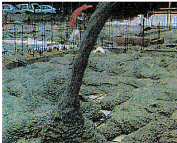
Σχήμα 10.31 Κόκκοι διογκωμένης πολυστερίνης για χρήση σε ελαφρά σκυροδέματα
