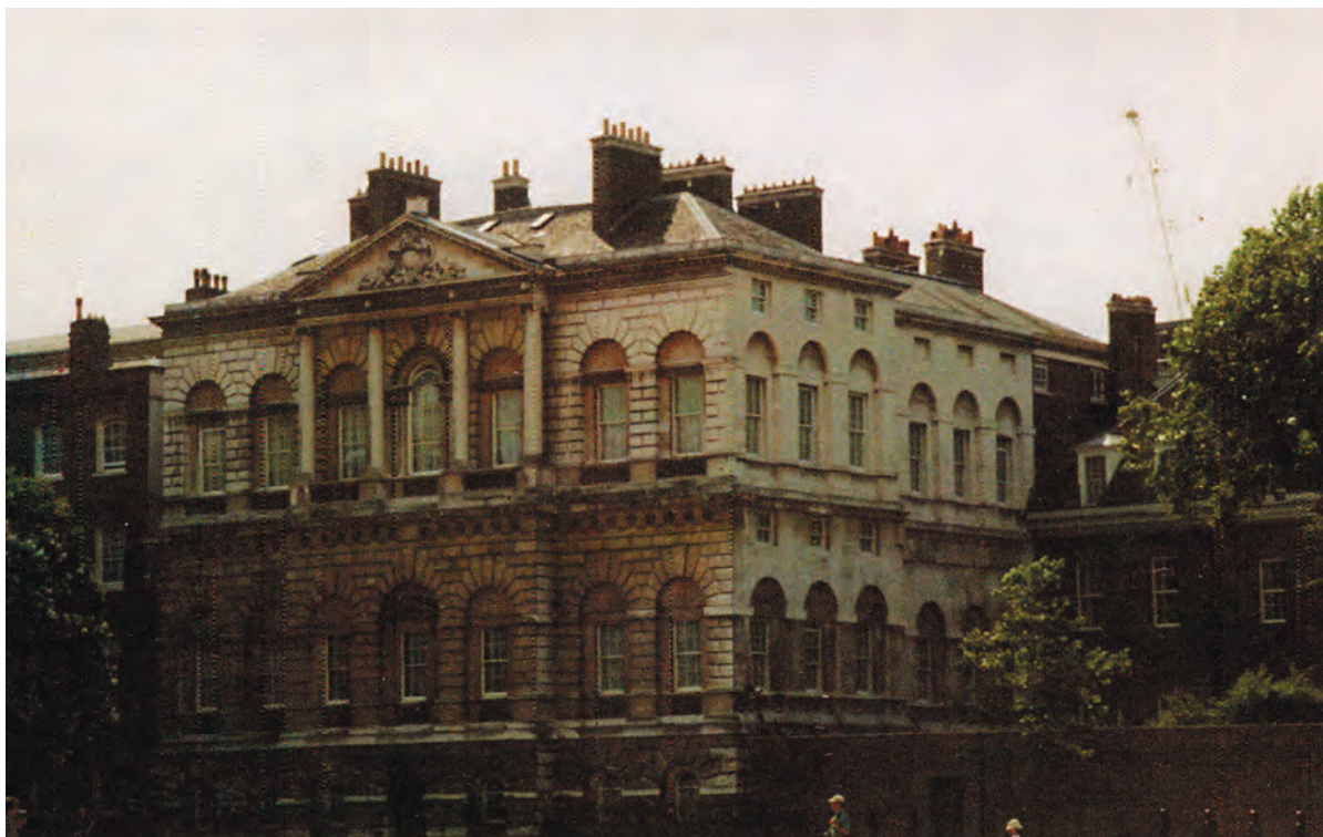
Σχήμα 5.3 Πέτρινο κτίριο στην περιοχή St. James Park του Λονδίνου
