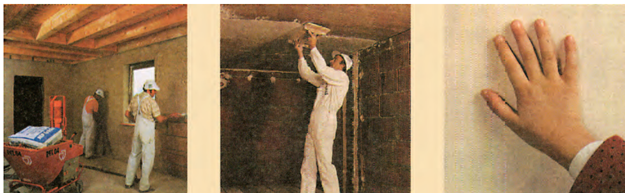
Σχήμα 8.3 Εφαρμογή κονιαμάτων
