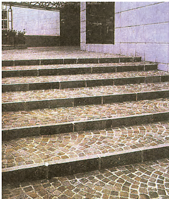
Σχήμα 11.7 Επίστρωση αναβαθμών με κυβόλιθους
