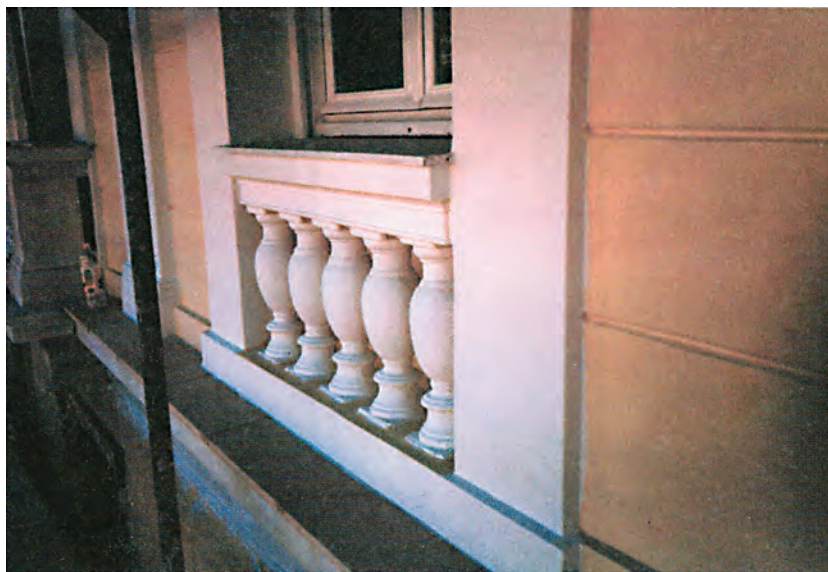
Σχήματα 8.9, 8.10 και 8.11 Αποκατάσταση ζημιών (κεραμικής μπαζούστρας) με χρήση επισκευαστικών κονιαμάτων (αρχείο Κ. Χατζηαντωνίου)
