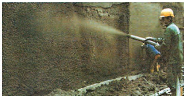
Σχήμα 10.32 Χρήση εκτοξευόμενου σκυροδέματος
