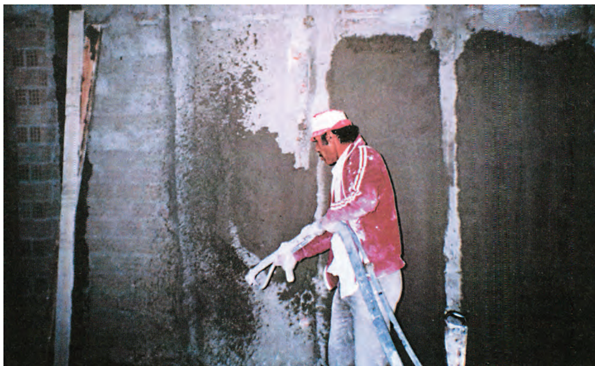
Σχήμα 8.15 Εφαρμογή έτοιμου σοβά
