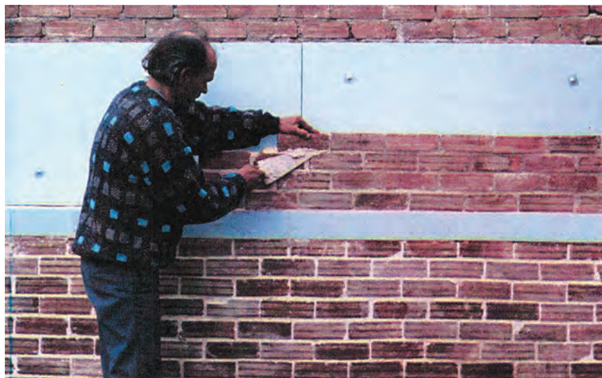
Σχήμα 16.2 Θερμομόνωση τοιχοποιίας
