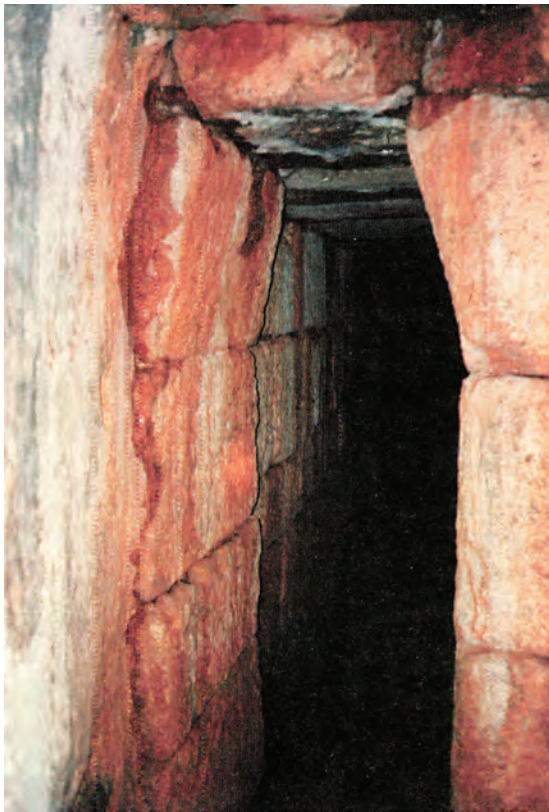
Σχήμα 2.3 Λεκέδες από άλατα σε σήραγγα αρχαίας πηγής "Βουρίνας" στην Κω (Αρχείο Κ. Χατζηαντωνίου)
