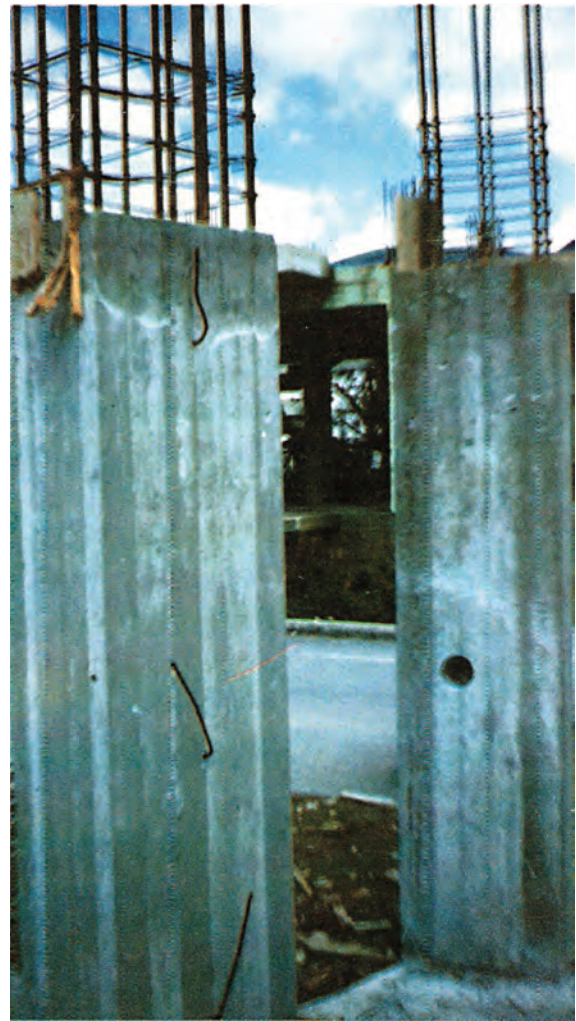
Σχήμα 10.18 Λήψη πυρήνα (καρότο) από υποστύλωμα
